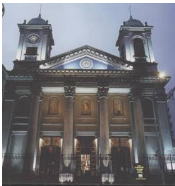
Figura 72 – Igreja do Salvador - Fachada
