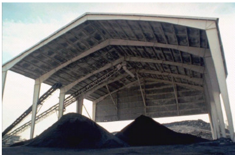
Figura 9: Estrutura para proteger e minimizar a umidade no material fresado (Fonte: Kandhal e Mallick (1997))
