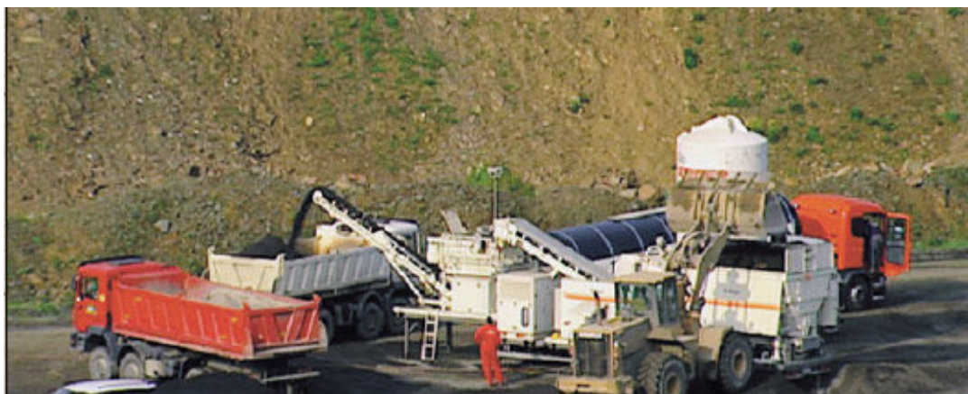
Figura 2: Reciclagem a frio em usina (Fonte: Wirtgen (2004))
