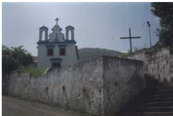
Figura 24 Escadaria de acesso
