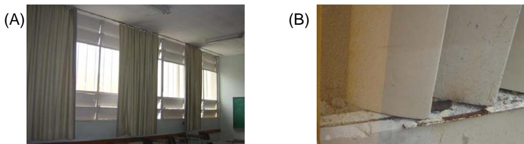
FIGURA 145 – (A) vista interna da sala de aula (B) detalhe da guia metálica enferrujada por falta de manutenção
