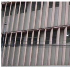
FIGURA 67– Vista dos *brise-soleils* verticais e inclinados
