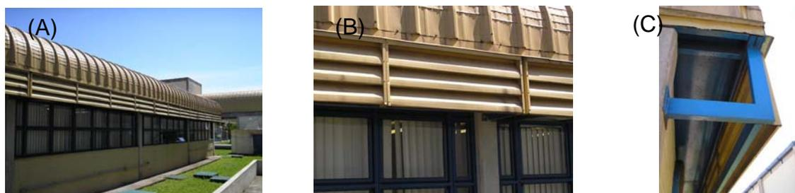
FIGURA 164 – (A) vista externa do *brise-soleil* horizontal (B) *brises* horizontais não prejudicam a luminosidade e visibilidade (C) detalhe dos *brises* abaixo da cobertura
