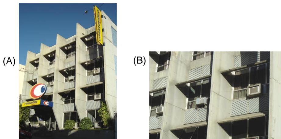
FIGURA 121 – (A) vista externa do Constantino Pré-vestibular (B) sombreamento dos brises horizontais e elementos verticais
