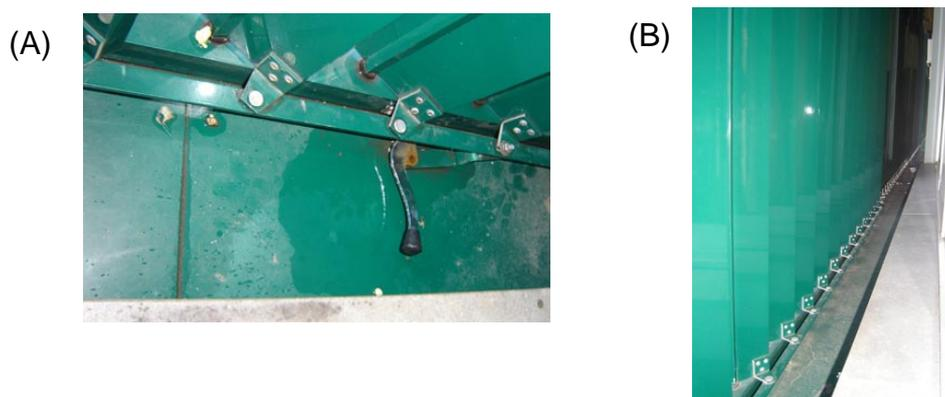
FIGURA 107– (A) detalhe da guia metálica e alavanca (B) espaço entre painéis e janela
