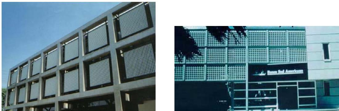
FIGURA 54 – Exemplos da aplicação do *Brise Cell*
