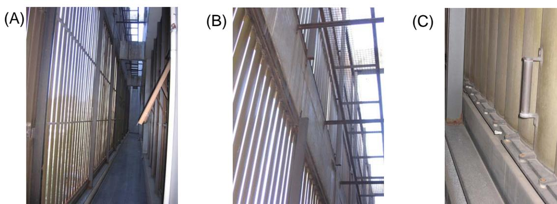
FIGURA 157 – (A) afastamento entre os *brises* e as aberturas (B) galeria com abertura superior (C) detalhe da alavanca responsável pela mobilidade dos painéis
