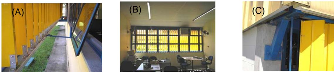
FIGURA 163 – (A) *brises* inseridos abaixo da cobertura (B) detalhe da alavanca para movimentação dos painéis (C) vista interna da sala
