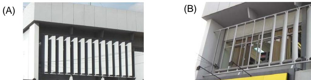
FIGURA 109 – Vista externa – (A) proteção dos *brises* contra o sol da tarde (B) cortinas e iluminação artificial
