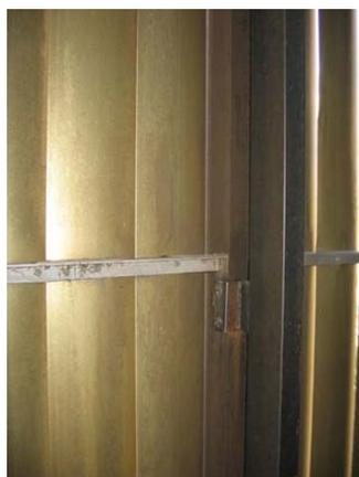
FIGURA 158 – Guia metálica que prende os painéis
