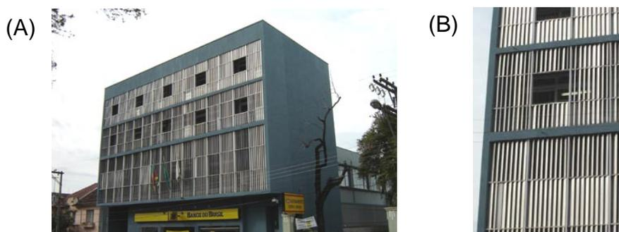
FIGURA 101– (A) Vista externa da edificação (B) vista da modulação dos *brises*
