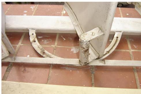
FIGURA 153 – Detalhe da alavanca que movimenta os painéis
