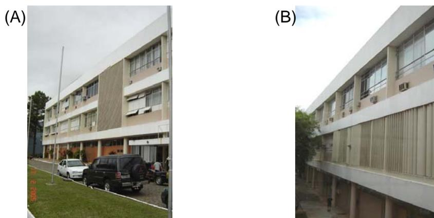
FIGURA 144 – Vistas externas – (A) fachada Leste com *brise-soleil* combinado (B) fachada Oeste com *brise-soleil* vertical
