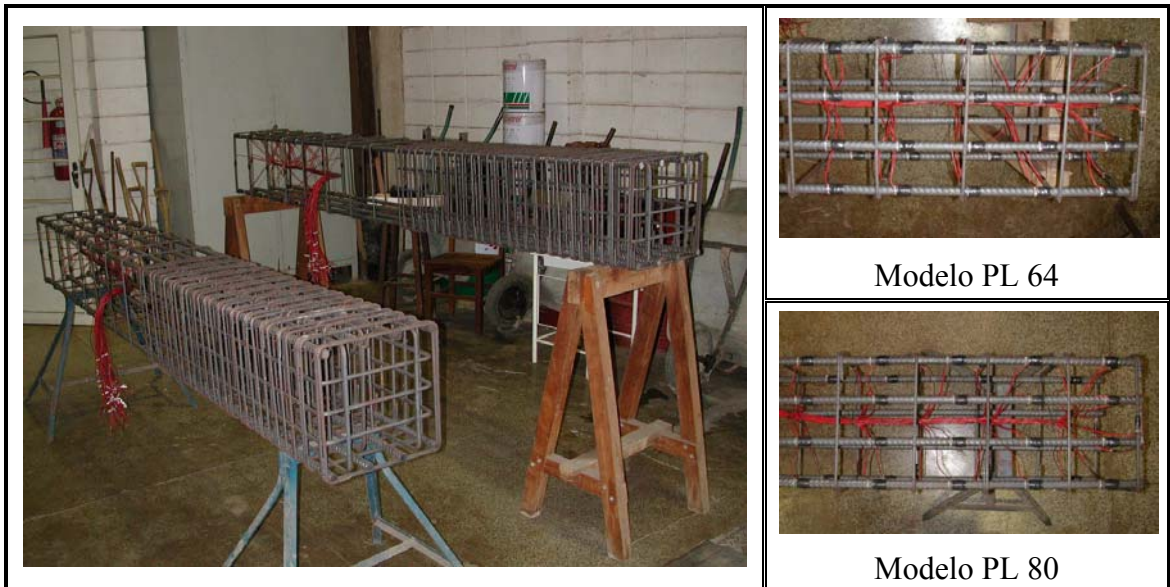
Figura 3.7 – Configuração final da armadura
