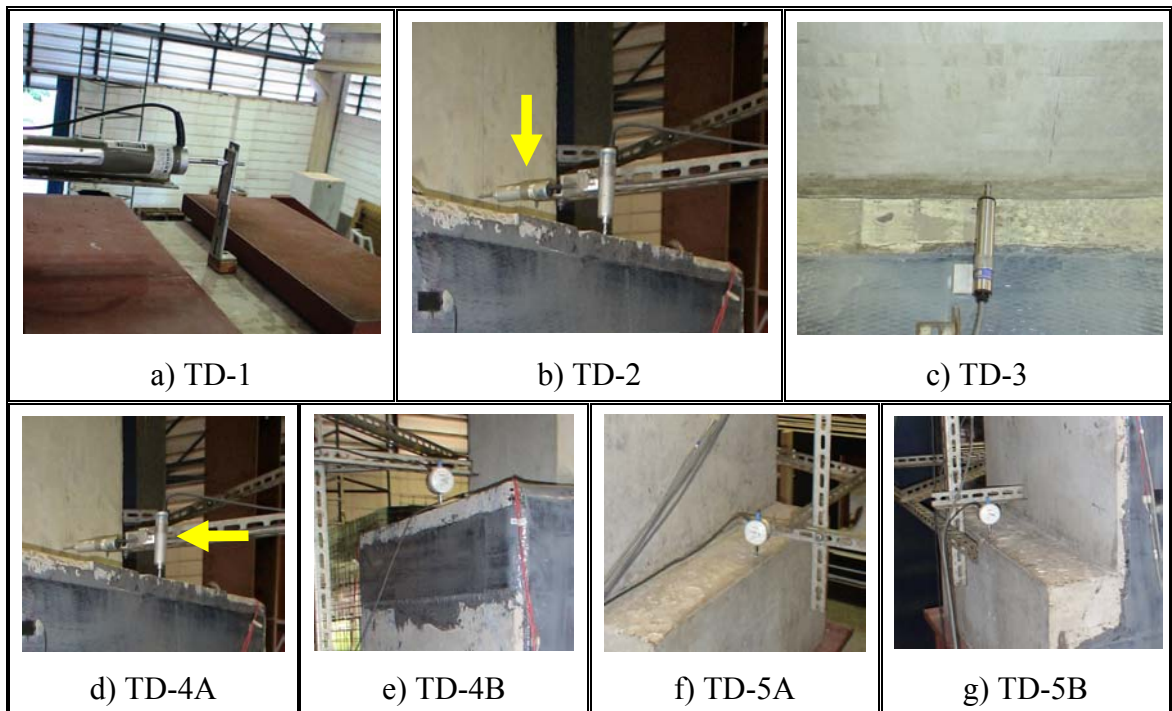
Figura 3.18 – Detalhe dos transdutores de deslocamento nos modelos
