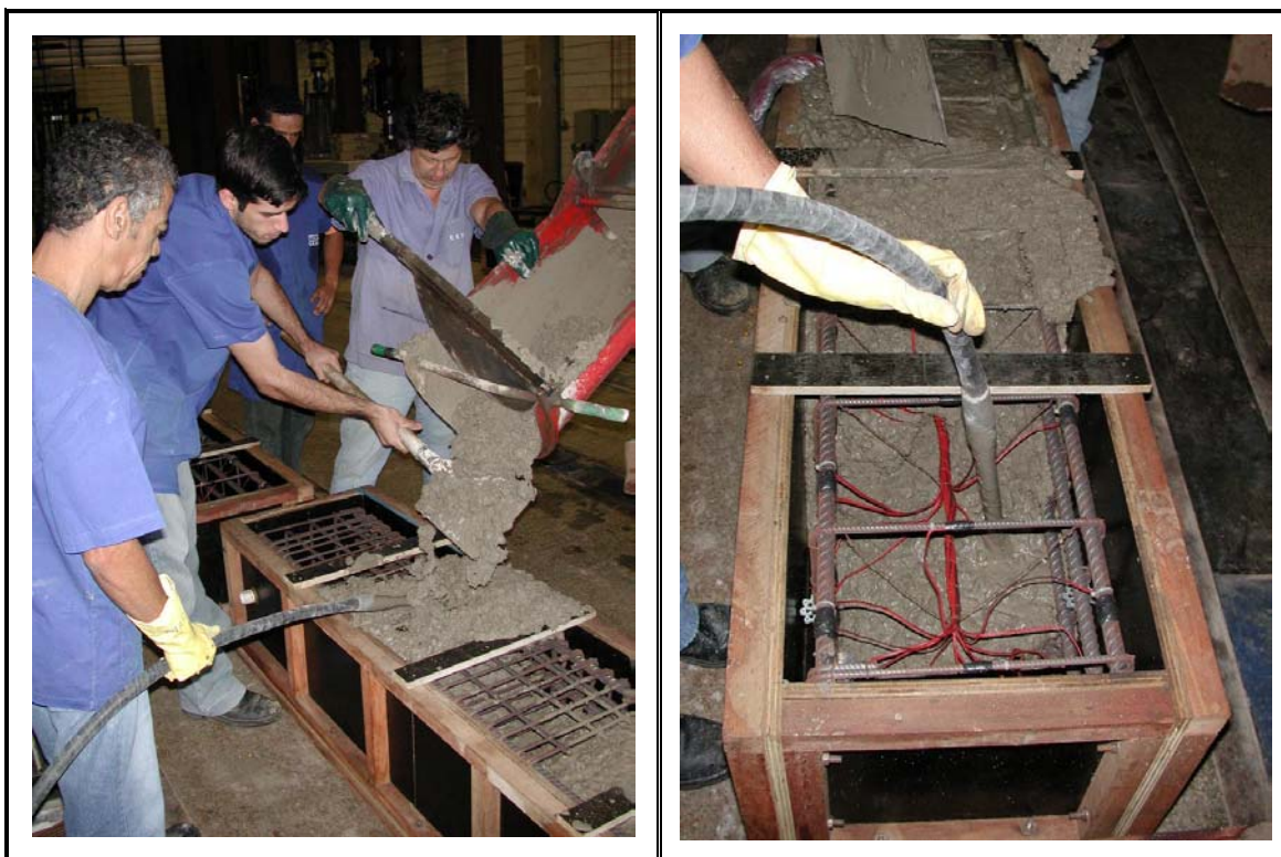
Figura 3.10 – Concretagem dos pilares
