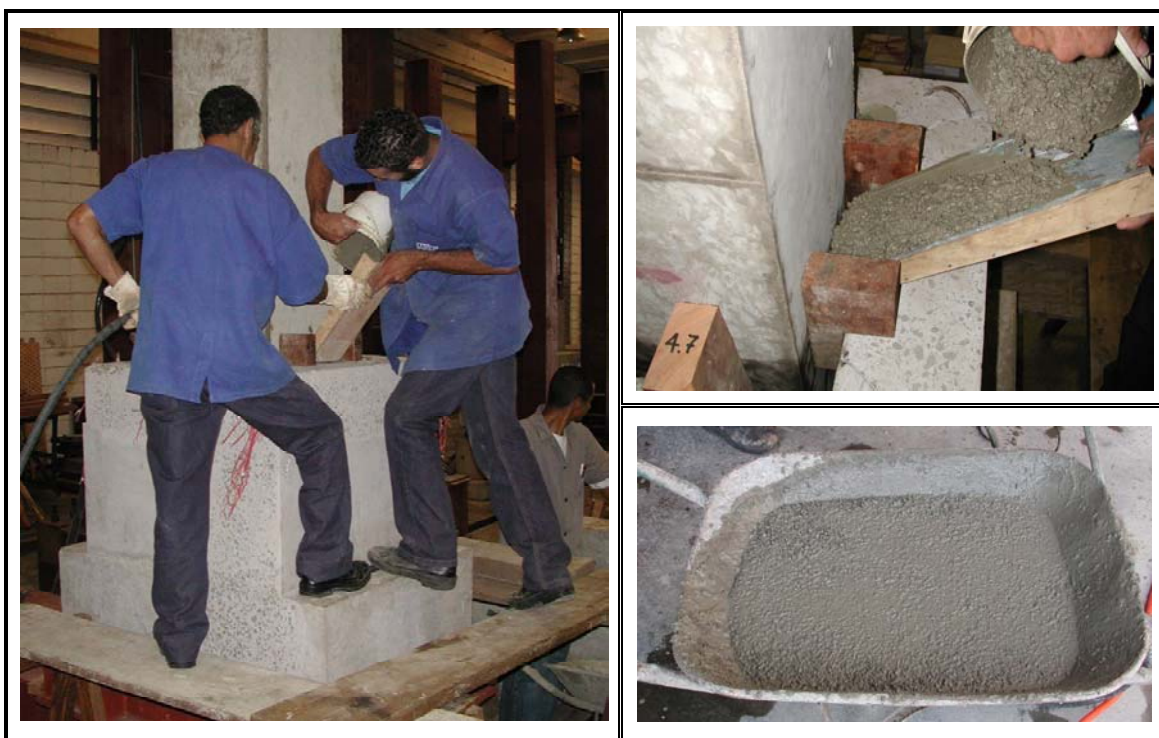
Figura 3.11 – Concretagem da junta dos modelos
