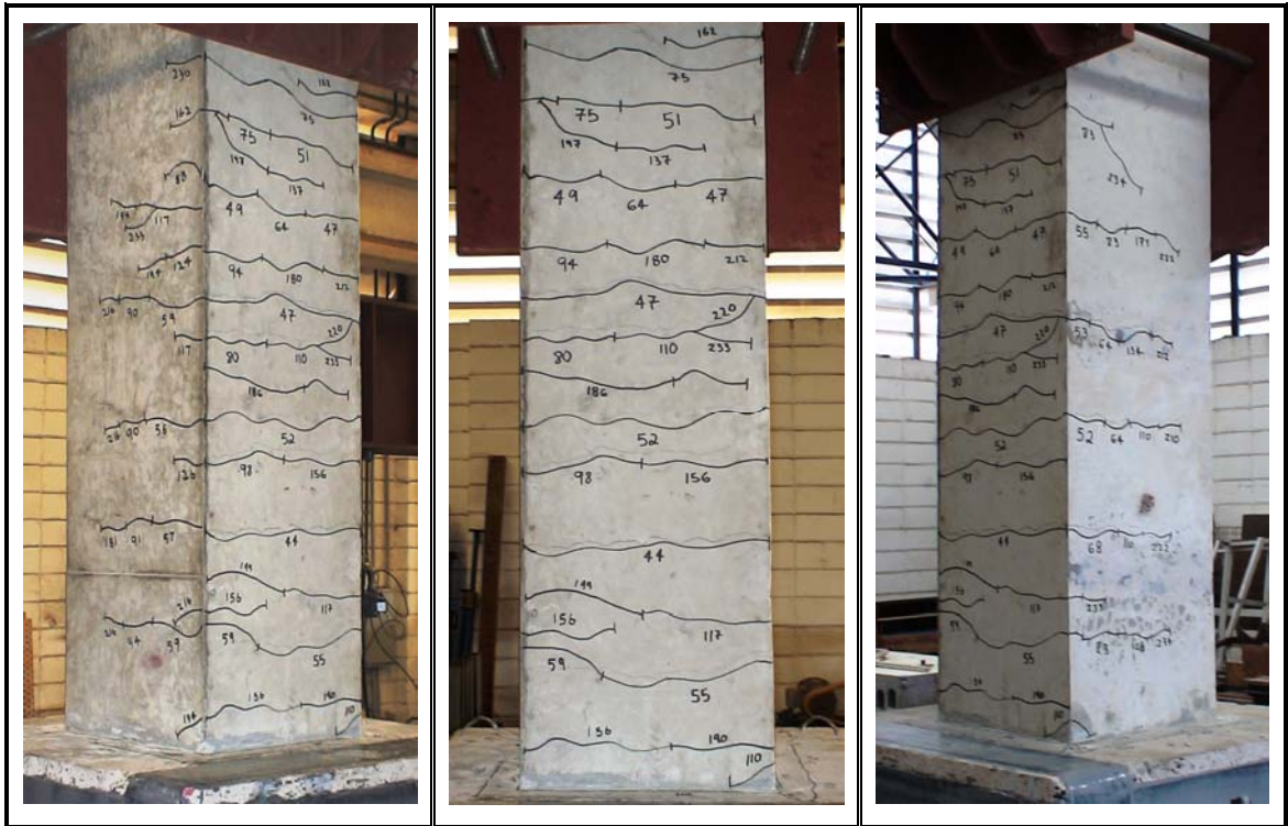
Figura 5.22 – Fissuração do pilar do modelo PL 64
