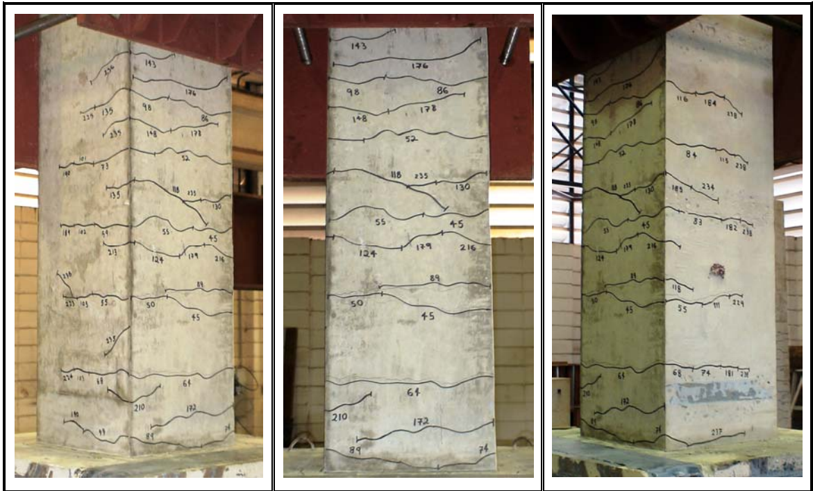
Figura 5.24 – Fissuração do pilar do modelo PL 80
