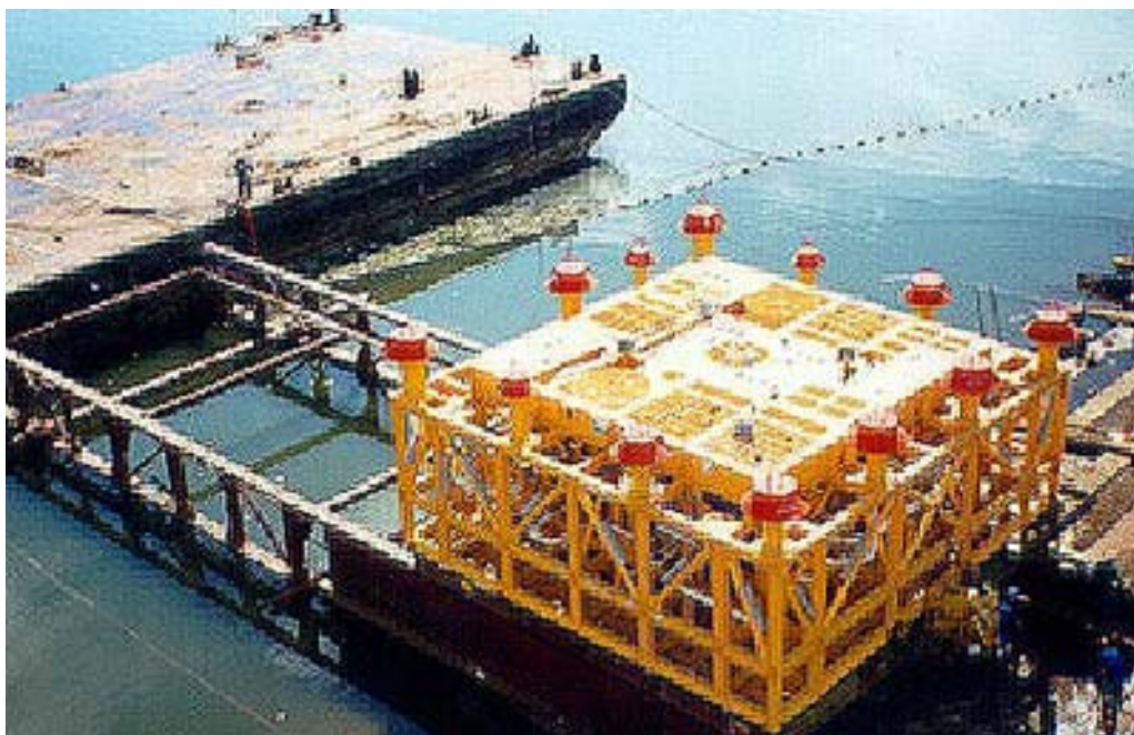
Manifold submarino instalado no campo de Marlim à profundidade de 800 metros
