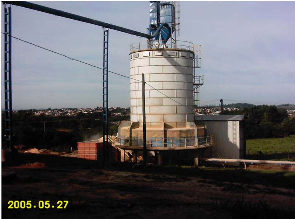
FIGURA 4 - Silo de material verde no pátio da Empresa Forjasul S.A, mostra uma tubulação que traz vapor para as estufas (reprodução autorizada).
