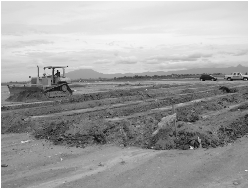
Figura 5 – Construção das leiras
