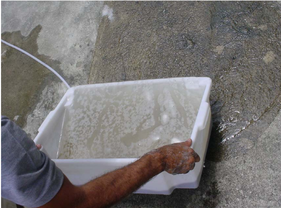
Figura 3.11- Eliminação do excesso de água do reservatório de lavagem da areia.
