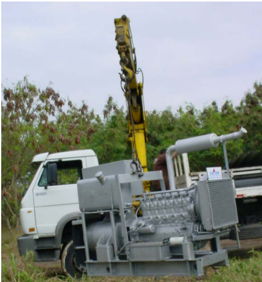
Figura 6.7- Gerador de energia utilizado na segunda campanha de ensaios sendo descarregado do caminhão munk.
