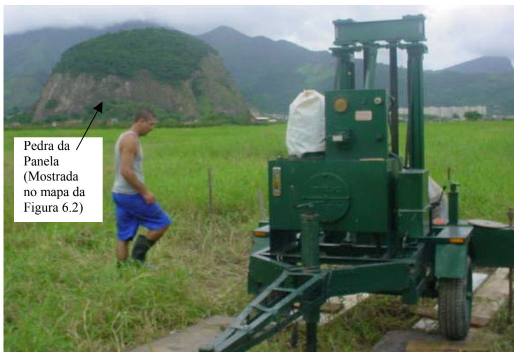
Figura 6.5- Local onde foram realizados os ensaios, com destaque às pranchas de madeiras utilizadas no transporte do equipamento de cravação.
