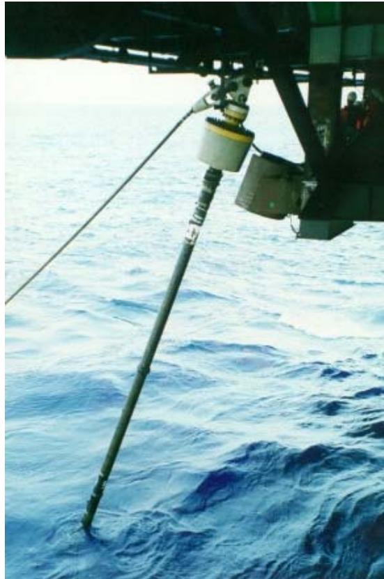
Figura 8-10 SCR sendo instalado na plataforma P18
