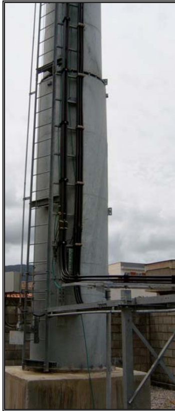
Figura VI.5 – Escada e esteira de cabos que vão do módulo M_8 ao M_1 [1]
