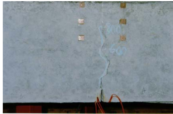
Vista do Meio do Vão
