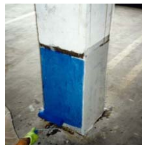
(f) Aplicação de Resina Epóxi Saturante na Superfície do Concreto
