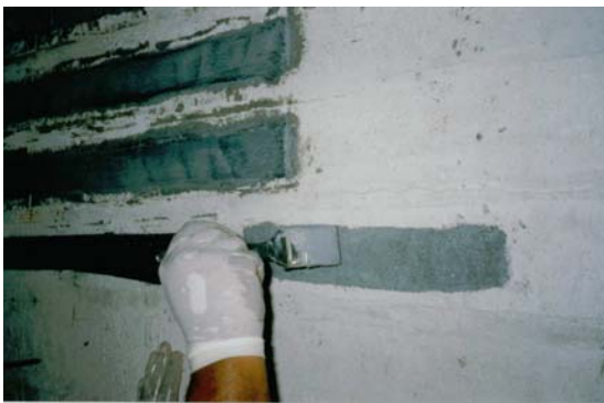
(c) Aplicação da resina epóxi na superfície do concreto
