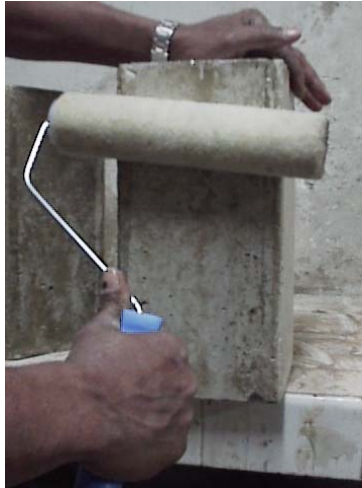
(a) Aplicação do primer na superfície de concreto por meio de rolo
