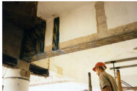
(f) Vista Após Aplicação de Argamassa Protetora e Pintura
