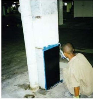
(g) Colocação da Primeira Folha de Fibras de Carbono Sobre a Superfície do Concreto
