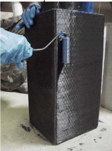
(e) Aplicação da folha de fibras de carbono na superfície de concreto com de rolo
