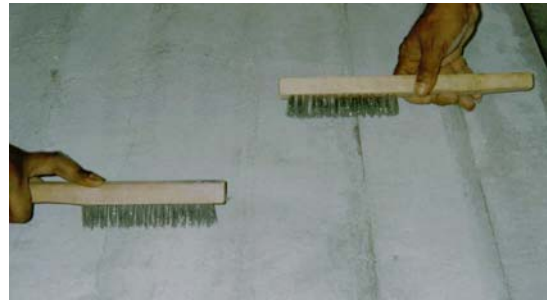
(b) Escovação da superfície do concreto
