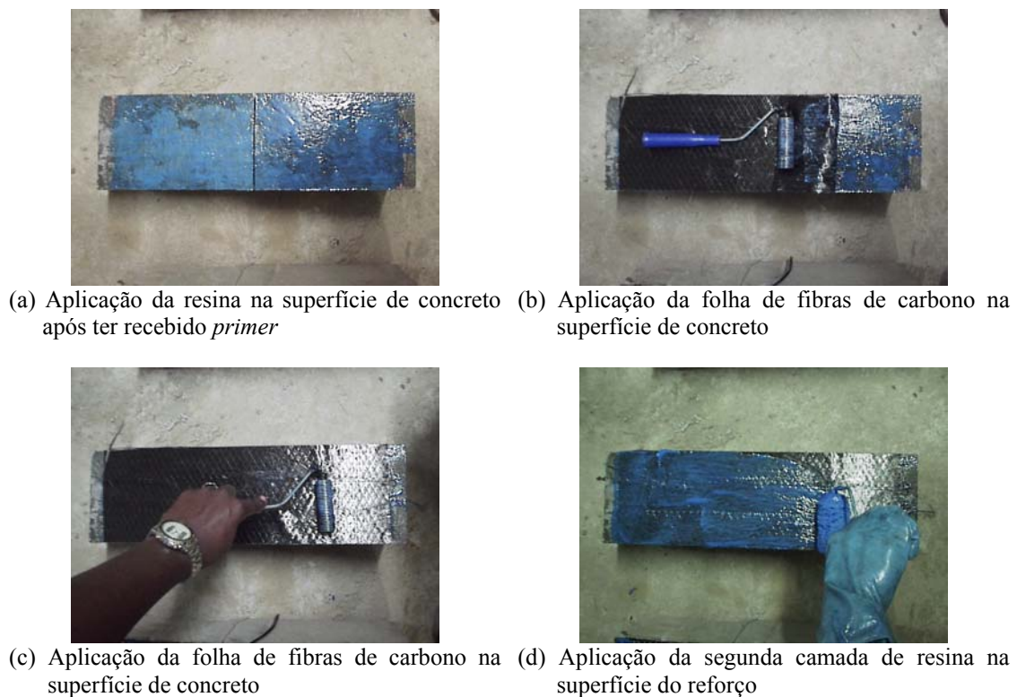
Figura 5.16 – Etapas de Execução do Sistema Compósito de Reforço Estrutural das Vigotas de Concreto Simples
