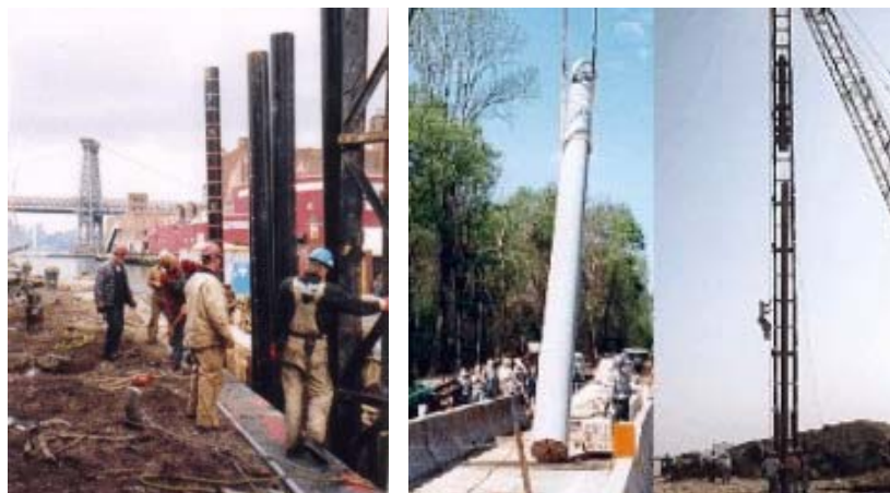
Figura 2.21 – Detalhe de Estacas de Tubos de Compósitos de Resina e Fibras de Vidro. Disponível em: < http://www.ecn.purdue.edu/ECT/Civil/cp40.htm >. Acesso em: jul. 2003
