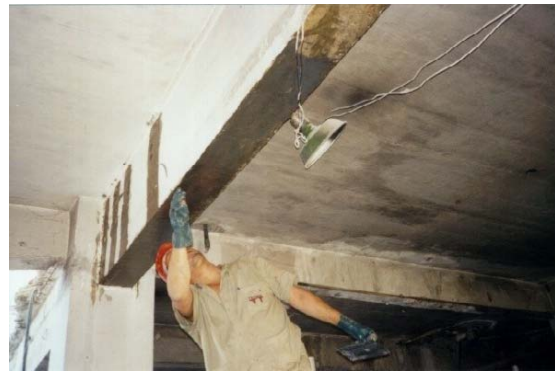
(b) Execução do Reforço à Flexão da Viga de Concreto
