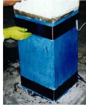
(h) Colocação da Segunda Folha de Fibras de Carbono Sobre a Superfície com Resina Epóxi
