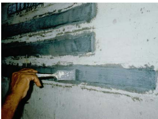
(d) Aplicação da segunda camada de resina na superfície do reforço
