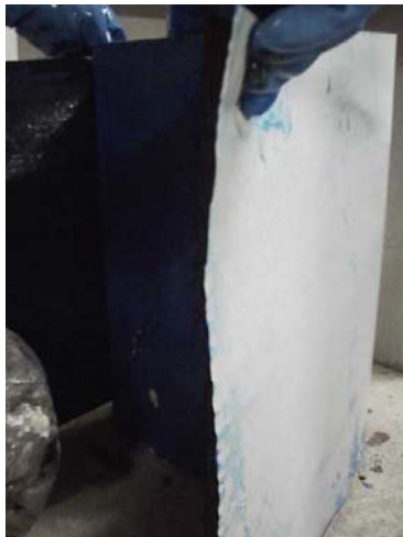
(d) Aplicação da folha de fibras de carbono na superfície de concreto após ter recebido resina
