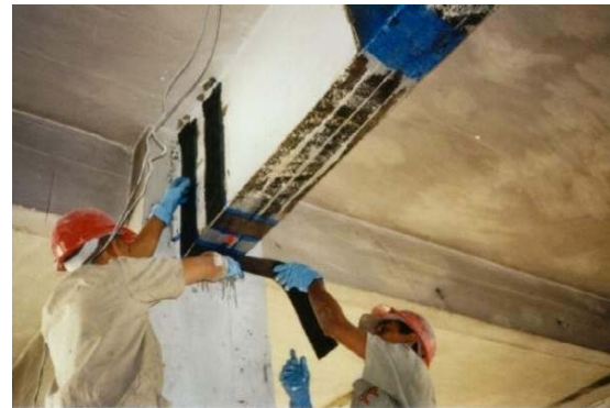
(d) Execução do Reforço ao Cortante da Viga de Concreto
