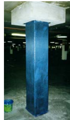
(j) Vista Completa do Pilar Após a Segunda Camada de Reforço
