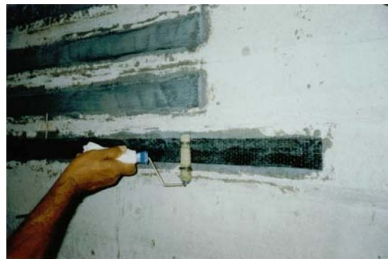
(c) Aplicação da folha de fibras de carbono na superfície do concreto
