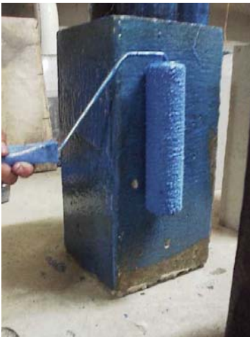
(c) Aplicação da resina na superfície de concreto após ter recebido primer
