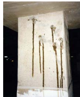
(b) Injeção de Resina Epóxi nas Fissuras
