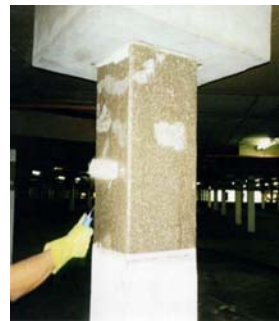
(d) Aplicação de Resina Epóxi Primer
