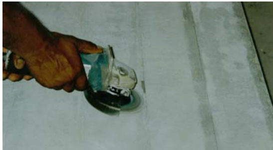
(a) Lixamento na superfície do concreto
