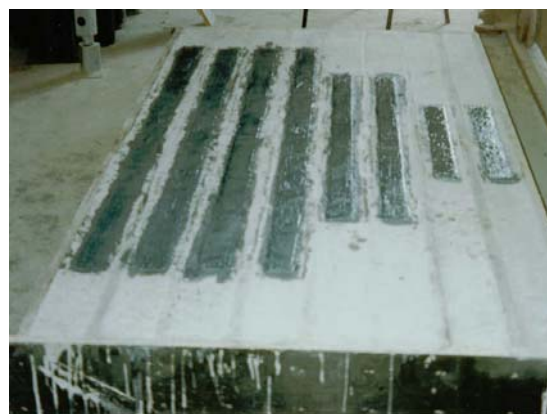
(e) Cura do material de reforço das vigotas de concreto armado
