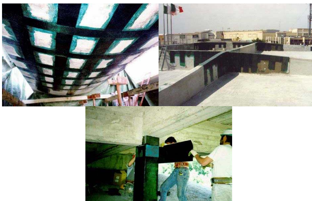
Figura 2.16 – Exemplos de Aplicação de Materiais Compósitos de Resina e Fibras no Reforço de Elementos Estruturais de Concreto. Disponível em: < http://www.shef.ac.uk/uni/projects/tmrnet/galleries >. Acesso em: nov. 2002
