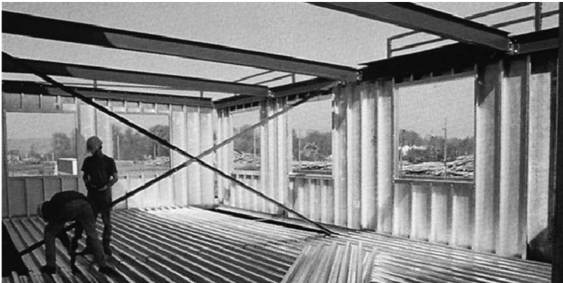
Figura 2.4 Vista de painéis diafragma.durante a construção de um edifício comercial [9]
