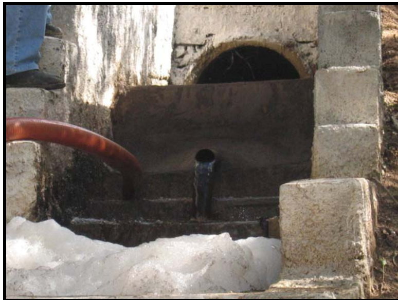
Figura 9.7: Chorume coletado sendo despejado em córrego à jusante do aterro 02
