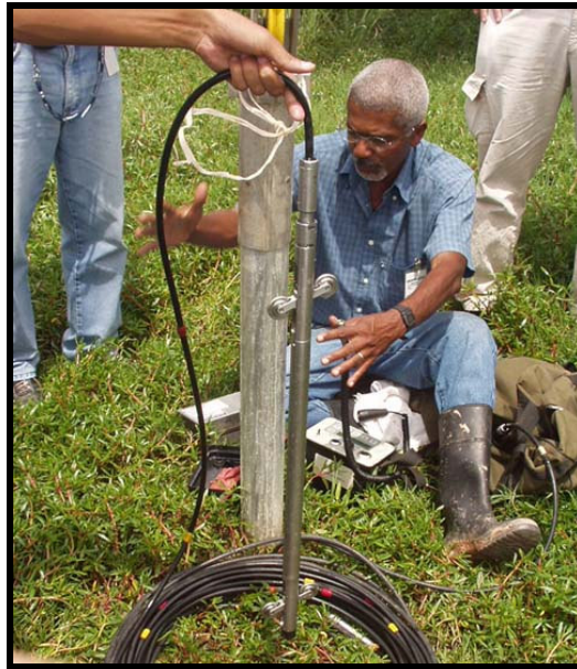
Figura 9.12: Inclinômetro utilizado no monitoramento da estabilidade dos maciços no aterro 03
