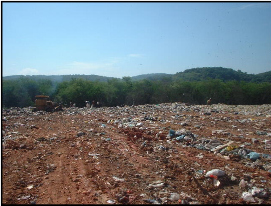
Figura 9.59: Disposição de lixo sem cobertura e compactação no aterro 15
