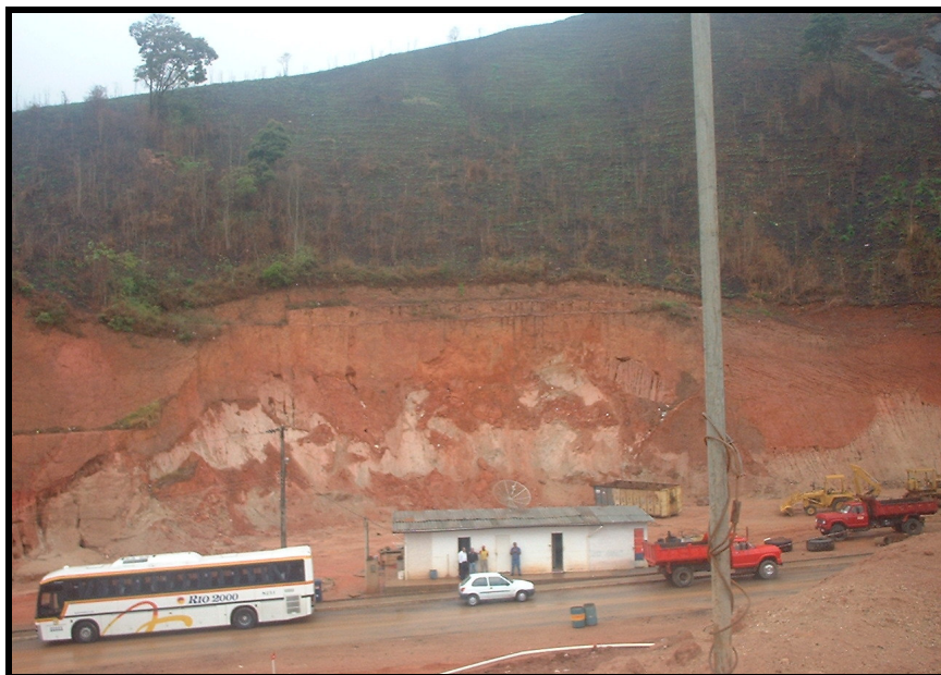
Figura 9.30: Controle de acesso ao aterro 06.
