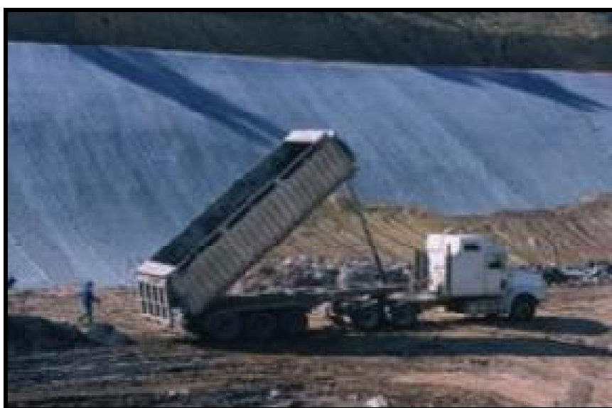
Figura 9.34: Descarga e aterramento de resíduos em rampa no aterro 07
