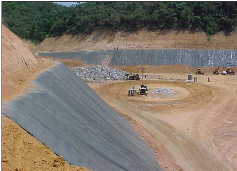
Figura 9.18: Manta de PEAD utilizada na impermeabilização do aterro 04.
