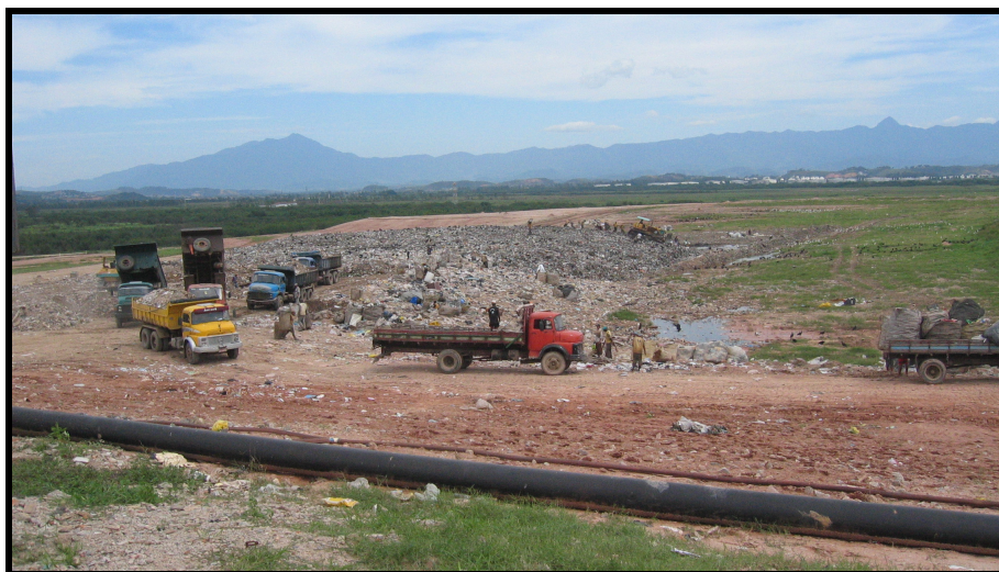
Figura 9.13: Frente de trabalho do aterro 03
