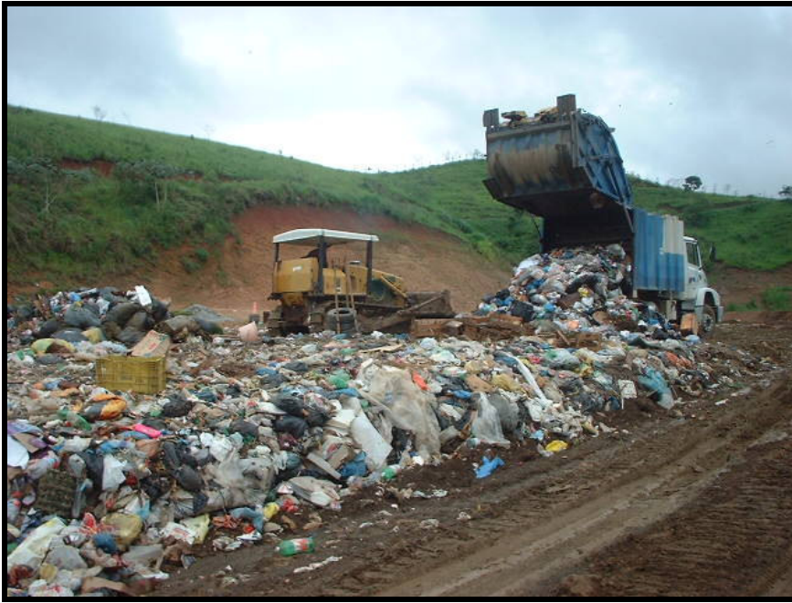
Figura 9.47: Execução de compactação e aterramento do lixo no aterro 11
