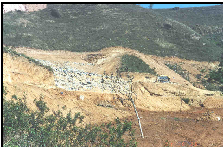
Figura 9.53: Lixo depositado a céu aberto sem nenhum controle no aterro 13.
