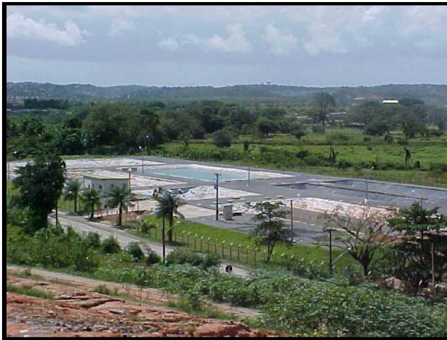
Figura 9.4: Estação Tratamento do Chorume no aterro 01
