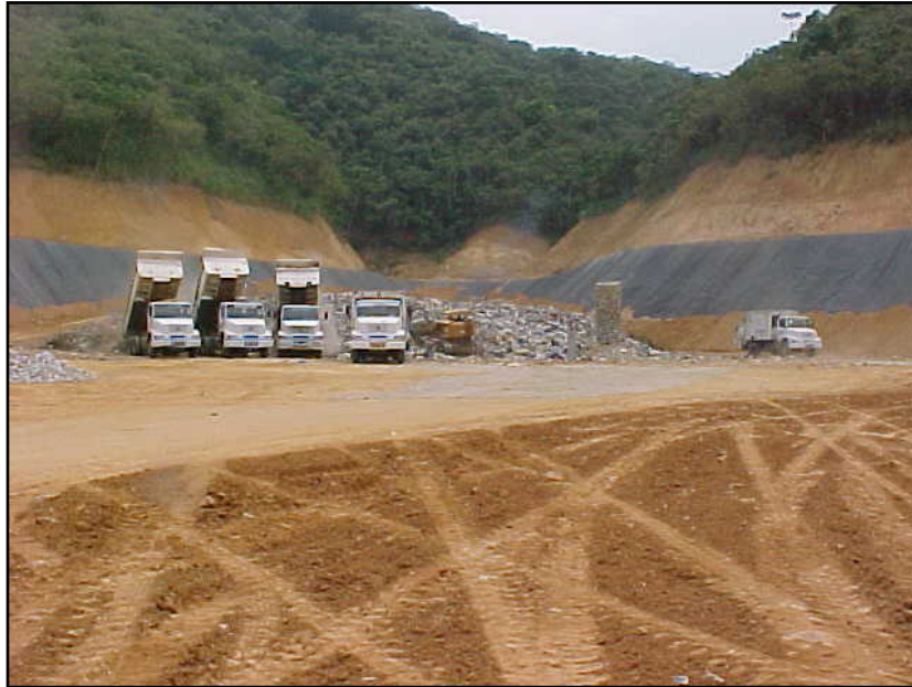
Figura 9.22: Frente de trabalho em execução no aterro 04.
