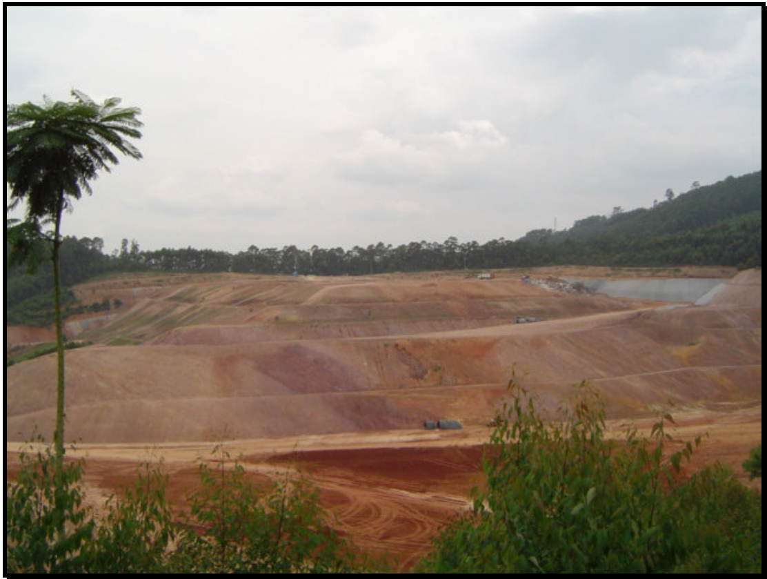
Figura 5.8: Aterro Sanitário (Foto: Aterro 07)
