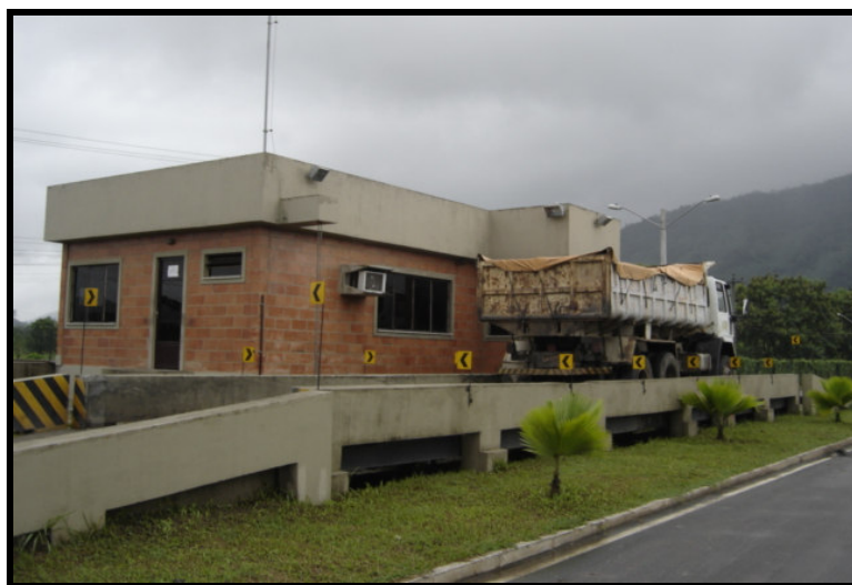
Figura 9.54: Controle de entrada e balança no aterro 14.
