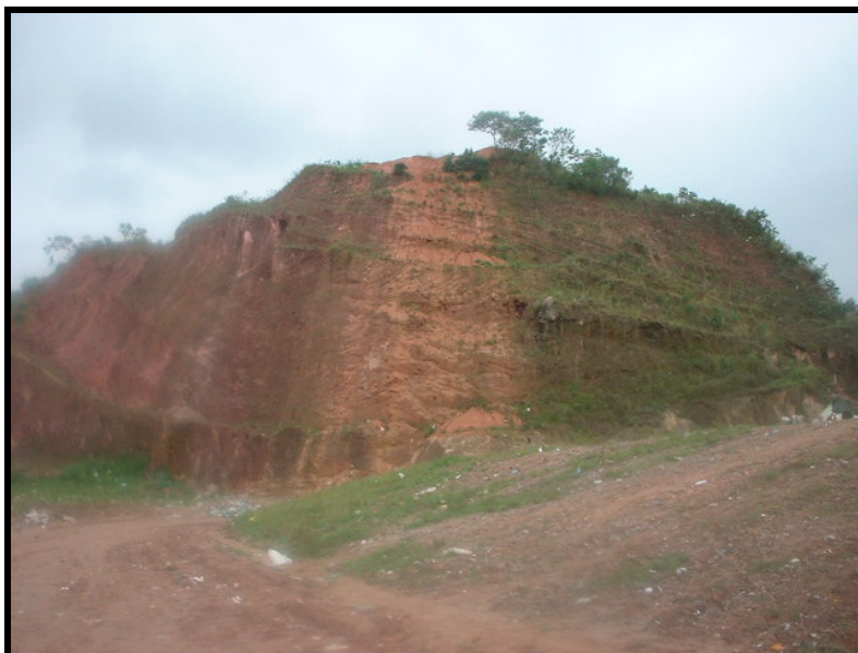
Figura 9.26: Jazida de material de recobrimento de lixo no aterro 05.
