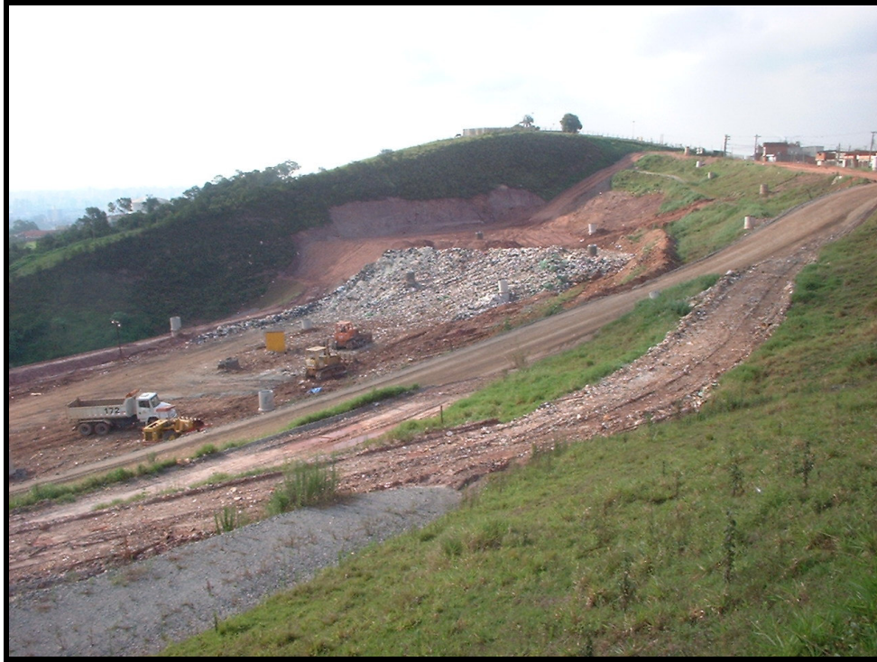
Figura 9.39: Frente de trabalho em operação no aterro 08.
