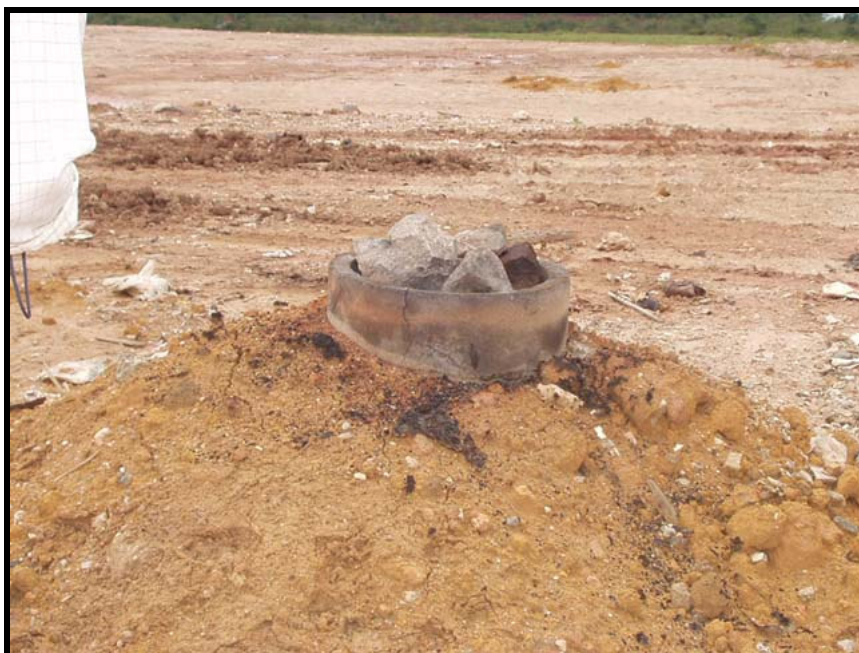
Figura 2.4: Queima do biogás direto em poço de aterro no Brasil
