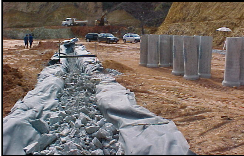
Figura 9.17: Execução de dreno para captação de nascente no fundo do aterro 04.
