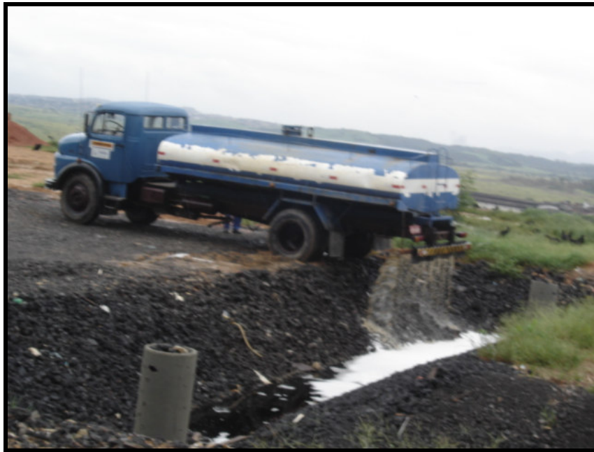
Figura 9.57: Recirculação de chorume no aterro 14.
