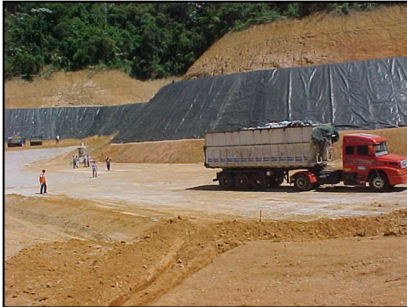
Figura 9.24: Acessos internos em perfeito estados de conservação no aterro 04.
