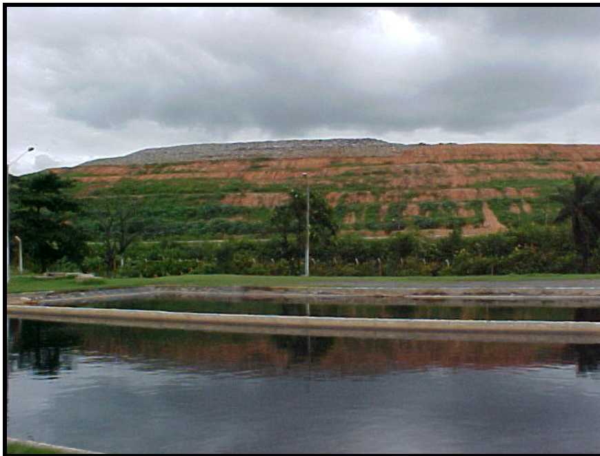
Figura 9.2: Vista de célula desativada com cobertura vegetal no aterro 01
