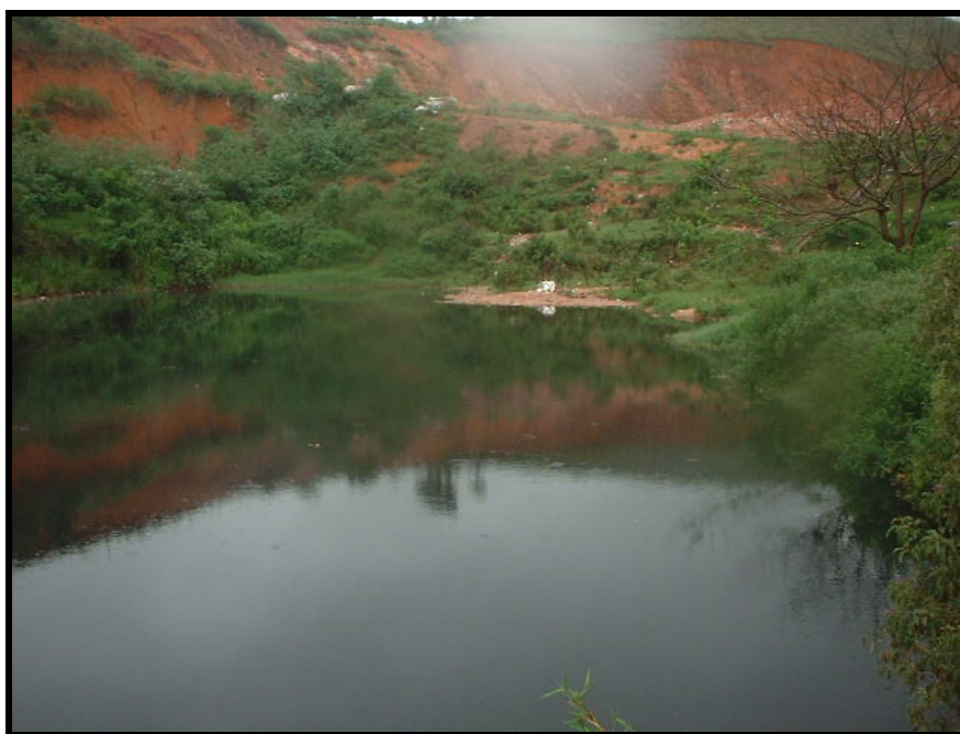
Figura 9.49: Lagoa de estabilização de chorume contaminando o solo e as águas subterrâneas no aterro 12.
