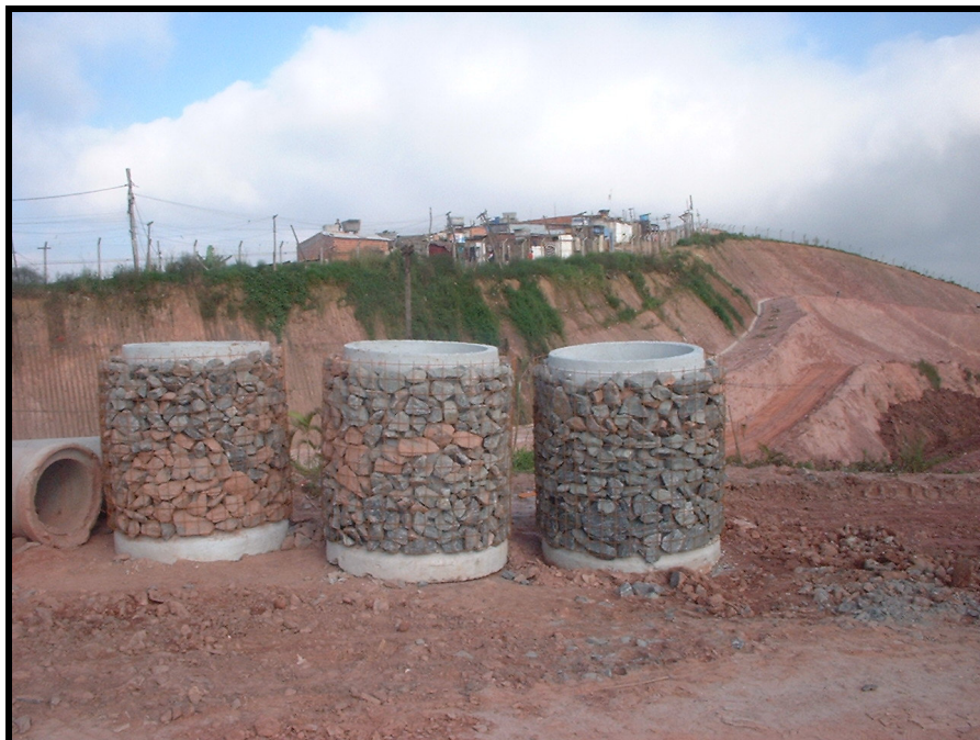
Figura 9.37: Drenos de gás prontos e favela colada à montante do aterro 08
