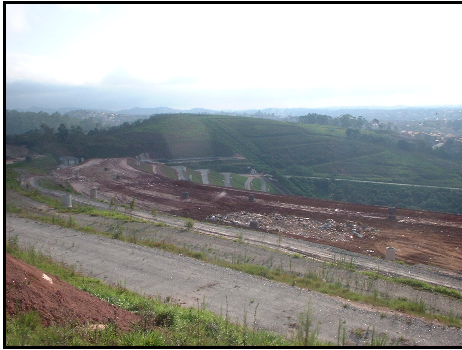
Figura 9.38: Visão geral e isolamento visual do aterro 08
