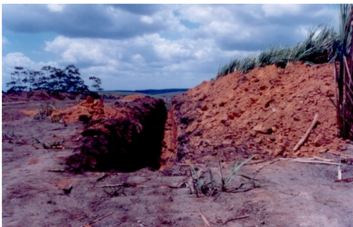
Foto 12: Detalhe da vala da tubulação de gás cortando a área da ocorrência 34.
