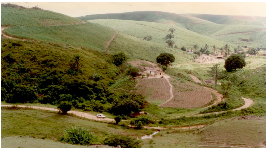
Foto 09: Km 48 do gasoduto. Município de Messias – Alagoas.
