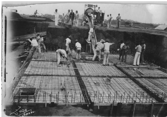
Figura 7. Construção da casa das bombas, para bombear água para a cidade de Uberaba, às margens do Rio Uberaba, 1940. Referência: Acervo da família Nassif.
