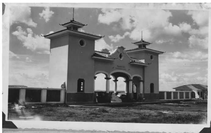
Figura 15. Entrada do Parque Fernando Costa, construído em estilo colonial meses antes da inauguração em 1941. Referência: Acervo da família Nassif.
