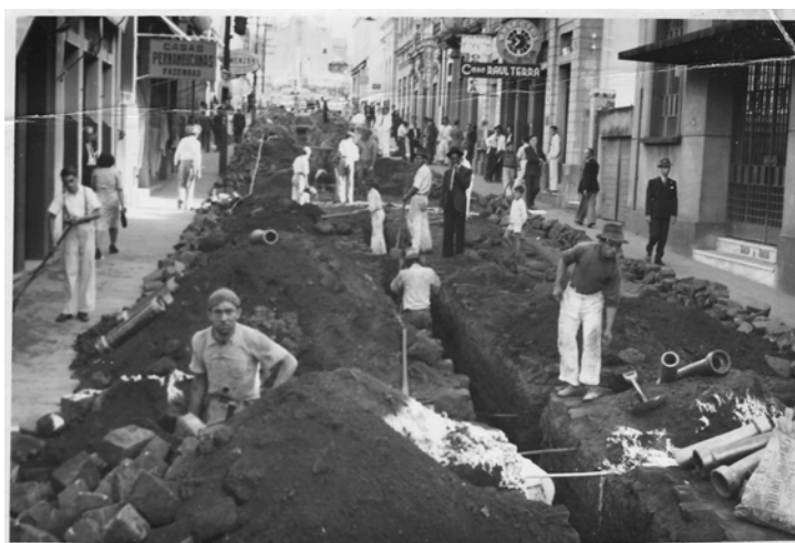
Figura 6. Instalação da rede de esgoto sanitário na Rua Arthur Machado, junho de 1942. Referência: Acervo da família Nassif.
