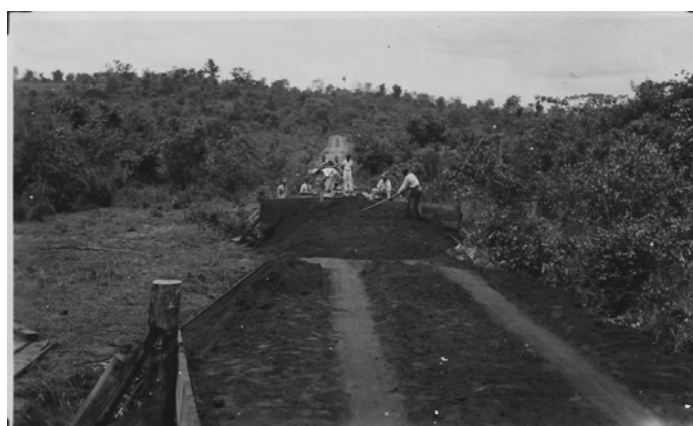
Figura 17. Construção de aterro em trecho da estrada entre Uberaba e Conceição das Alagoas, 1942. Referência: Acervo da família Nassif.
