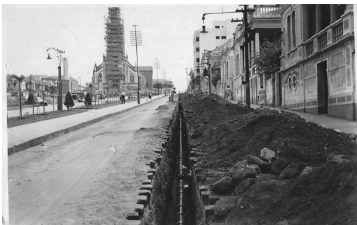
Figura 8. Instalação da rede de água encanada na Praça Rui Barbosa em 1942.
