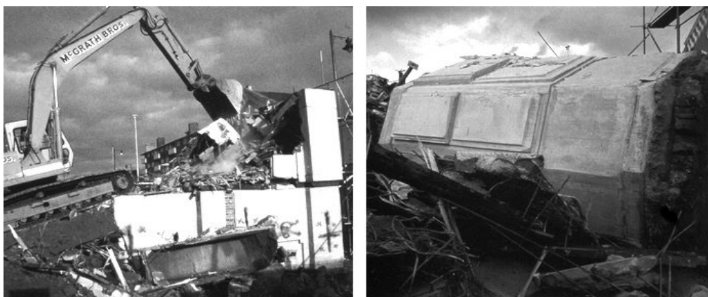
FOTO 25 e 25 A - Demolição da Casa
