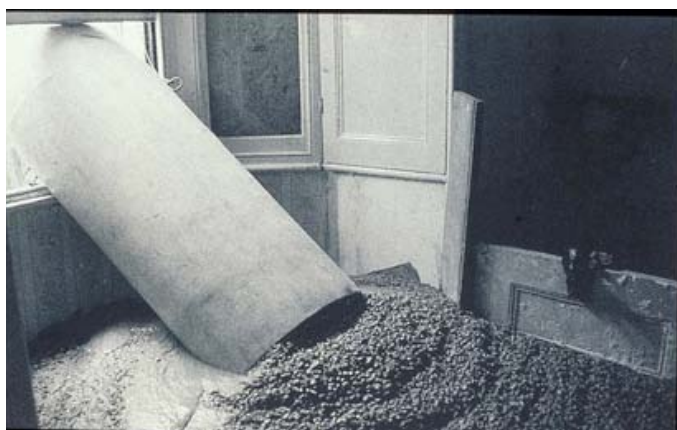
FOTO 17 - Injeção de concreto no interior da casa – Rachel Whiteread “House” 1993
