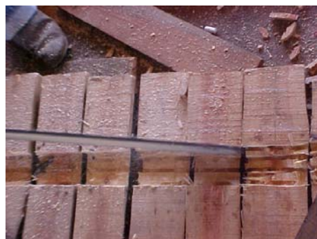
2. Execução dos canais para as travessas
