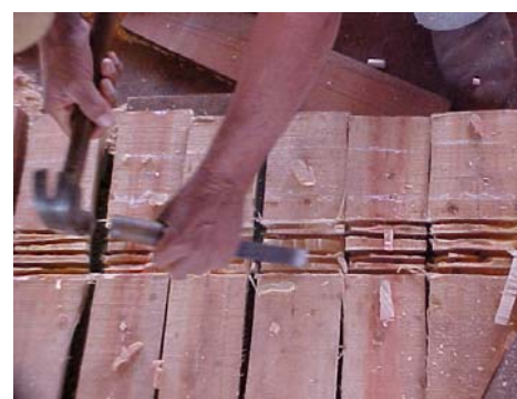
2. Execução dos canais para as travessas
