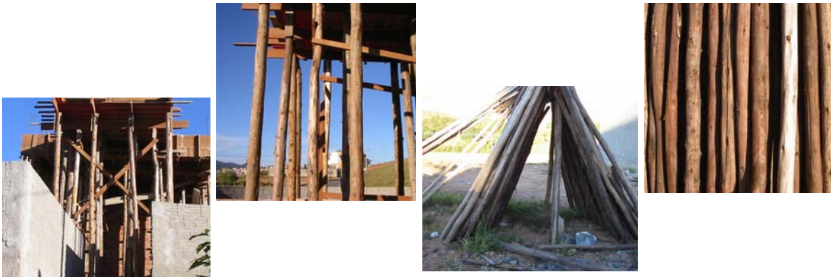
Figura 7 - Utilização e deposição de escoras
