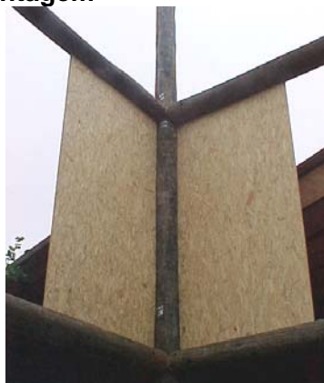
1. Posicionamento das chapas
