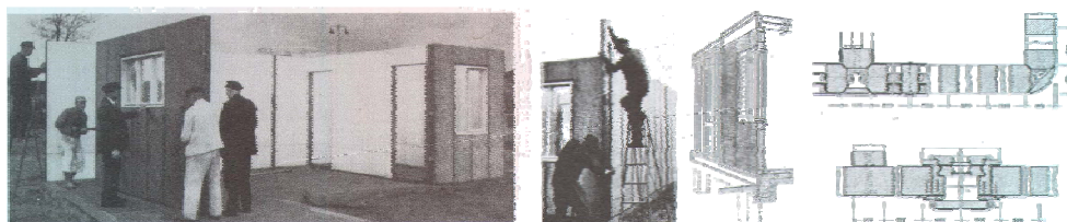
Figura 12- Casa Kupfer de Finow, seqüência de montagem das paredes pré-fabricadas e os detalhes de um elemento parede em corte
