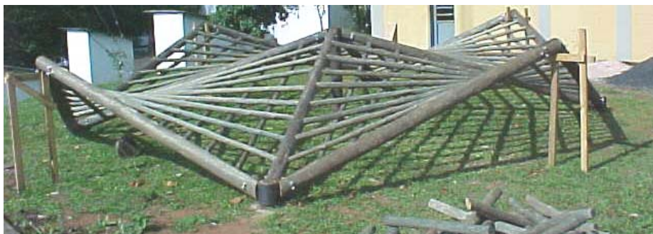
Figura 5 - Montagem da estrutura de cobertura do edifício experimental LaMEM - EESC -USP (2005)
