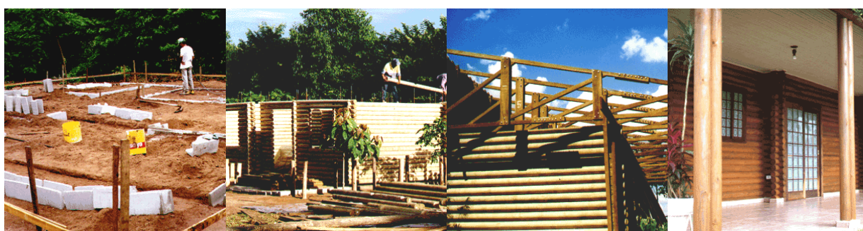
Figura 10 - Etapas de montagem executadas pela empresa Casabella
