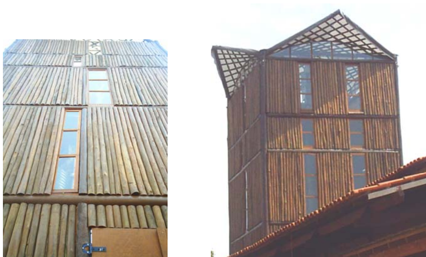
Figura 40 – Edifício Experimental composto por painéis em chapas OSB e ½ peças roliças de eucalipto com pequeno diâmetro construído no LaMEM- EESC-USP
