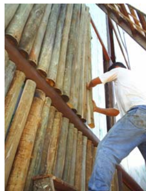
2. Posicionamento das peças em obra
