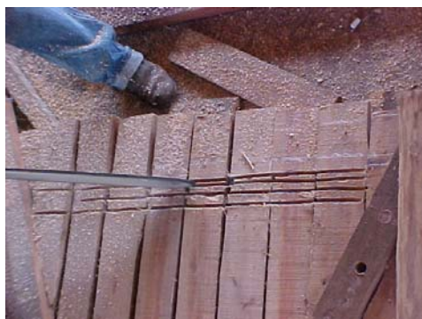
2. Execução dos canais para as travessas
