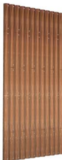
Figura 49 – Painel estrutural composto por chapa OSB e “metrinho” pregado
