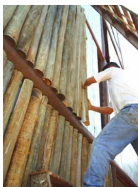
2. Posicionamento das peças em obra
