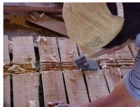
2. Execução dos canais para as travessas
