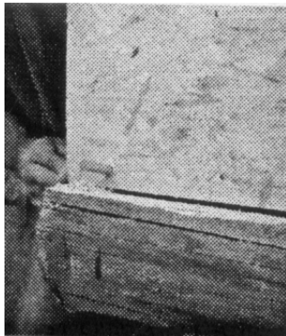
0. Fixação das chapas de OSB
