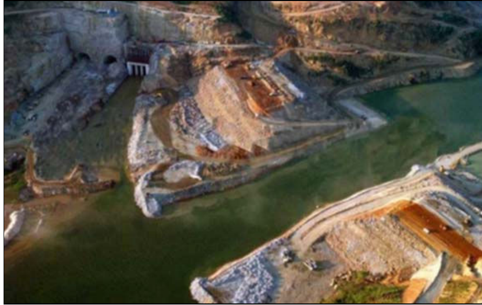
Figura 84: Barragem de Itapebi-BA (Fonte: http://www.sbbengenharia.com.br/ )
