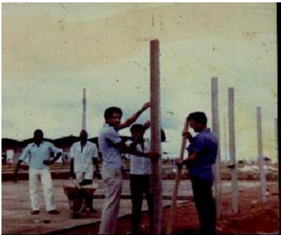
FIGURA 15: Foto da construção da quadra de esportes, realizada em sistema de mutirão.
