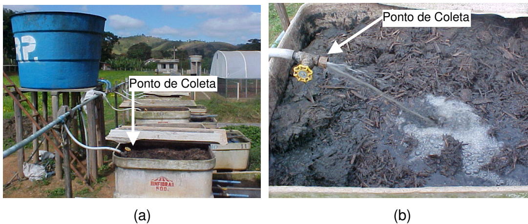
Figura 9. Sistema de distribuição e aplicação nos filtros orgânicos (a) e detalhe do ponto de coleta “antes do filtro” (afluente do filtro orgânico) (b)
