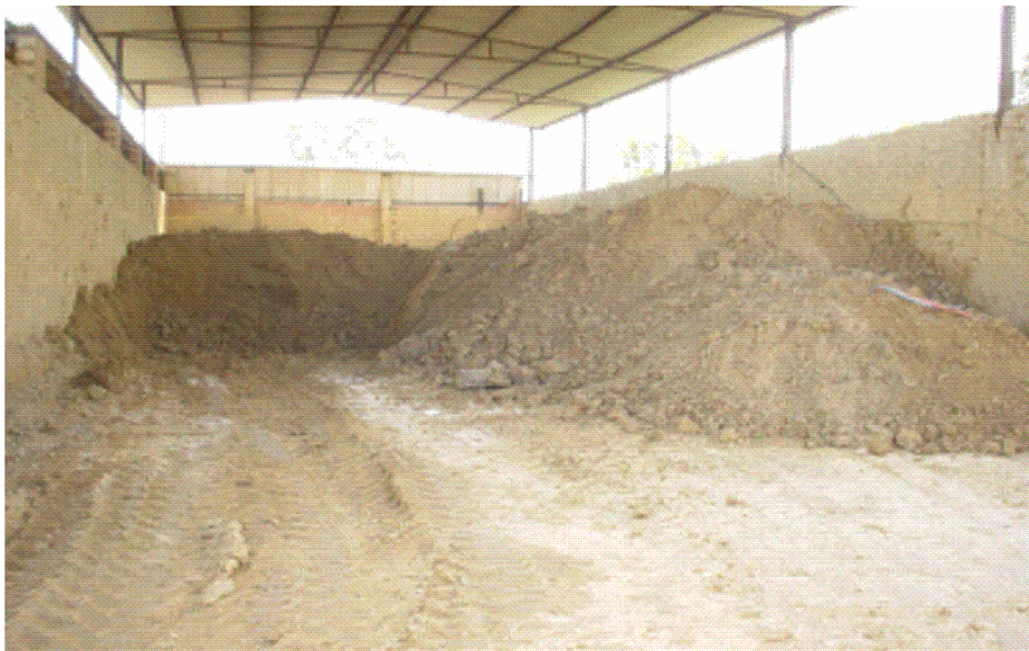
Foto II.5: Depósito de argila coberto
