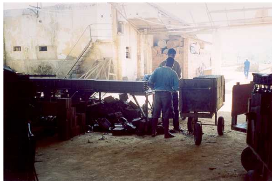
Foto II.19: Transporte manual dos blocos para as vagonetas
