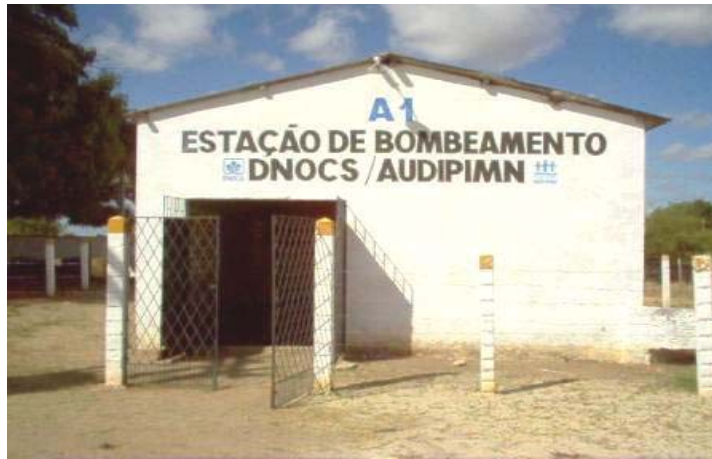
Figura 14: Estação de Bombeamento A1 Fonte: Pesquisa Direta,2005.
