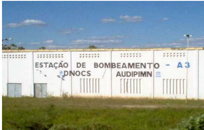
Figura 16: Estação de Bombeamento A3 Fonte: Pesquisa Direta, 2005.
