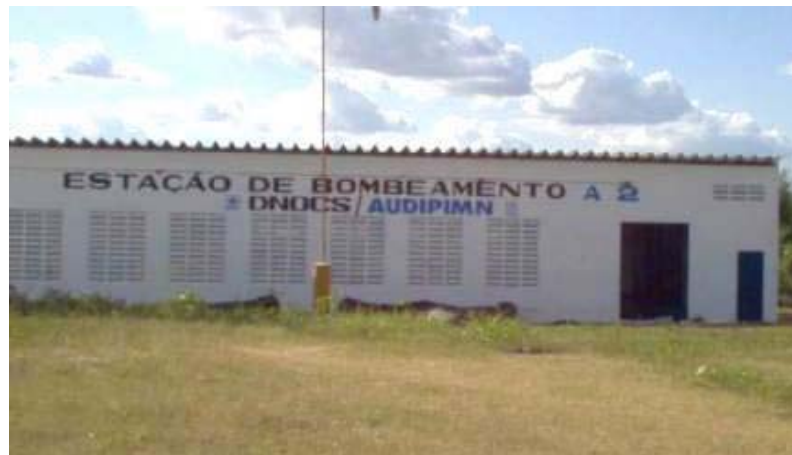
Figura 15: Estação de Bombeamento A2 Fonte: Pesquisa Direta,2005.
