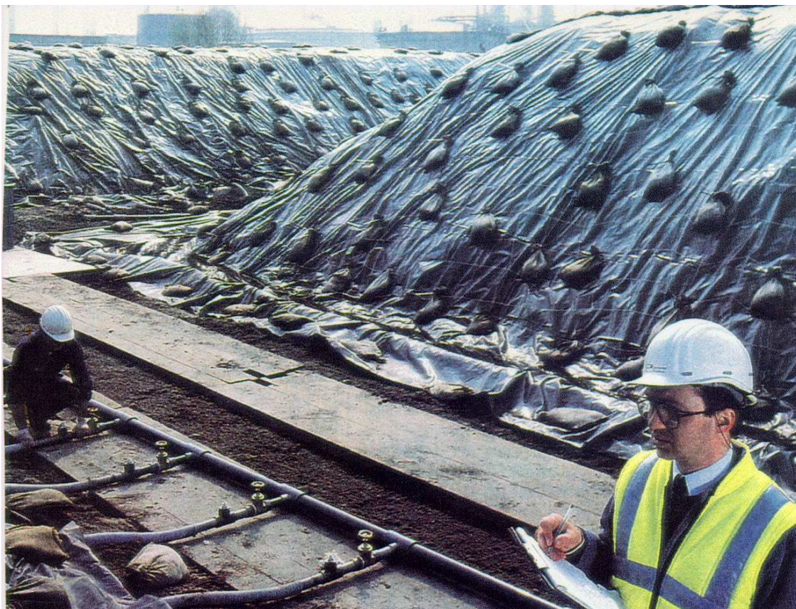
Figura 3.7 – Esquema típico de um sistema de biopilha estática (LEAHY e BROWN, 1994).
