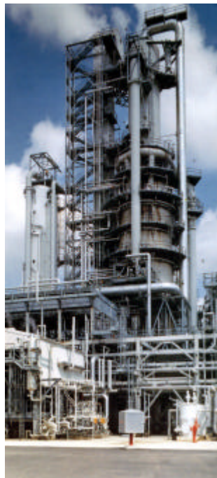
Figura 2.4 – Modelo Ultra Orthoflow em refinaria na Philadelphia
