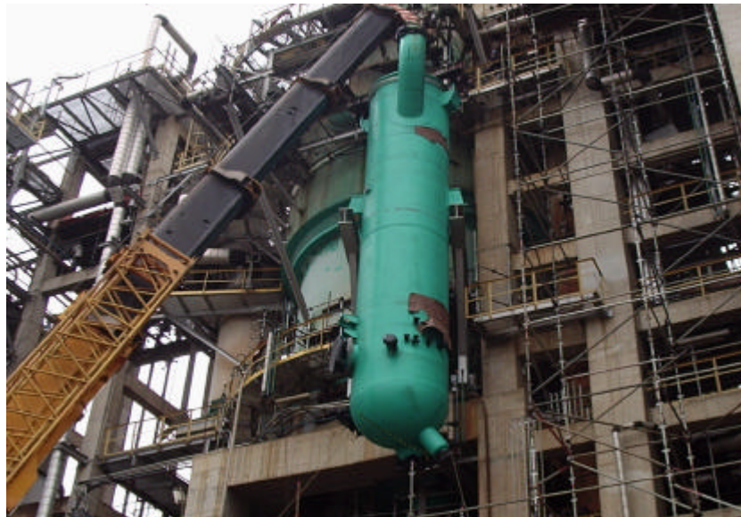
Figura 2.8 – Montagem de resfriador de catalisador para o IsoCat ®
