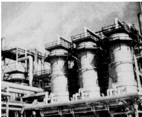
Figura 2.1 – Unidade industrial do processo Houdry com reatores catalíticos de leito fixo em primeiro plano
