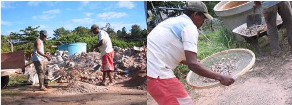
Figura 6 - Peneiramento do material grosso em tela de malha de 3,0 cm x 3,0 cm (a) à esquerda e peneiramento do material fino em peneira de malha de 0,5 cm x 0,5 cm (b).à direita.
