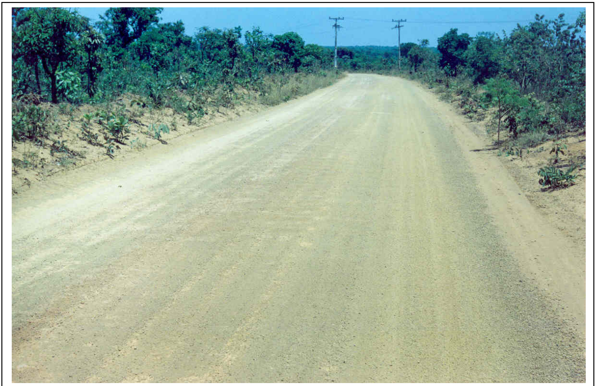
Figura 26 - “Estrada da Patrulha” que corta o CIF, de Norte a Sul.
