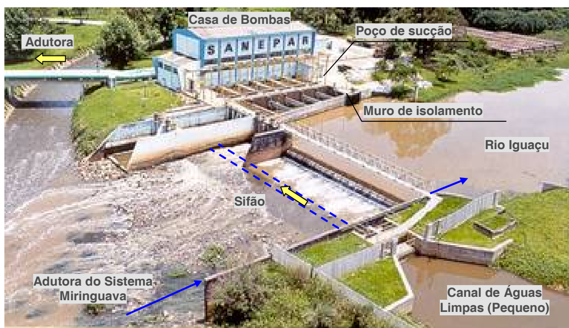
FIGURA 4.21 CAPTAÇÃO NO RIO IGUAÇU DA SANEPAR
