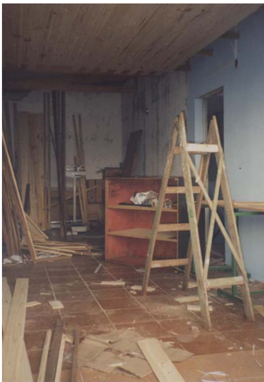
Fig. 24 - Construção da Escola de Passagem
