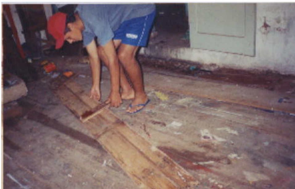
Fig. 25 - Adolescentes trabalhando na construção da escola
