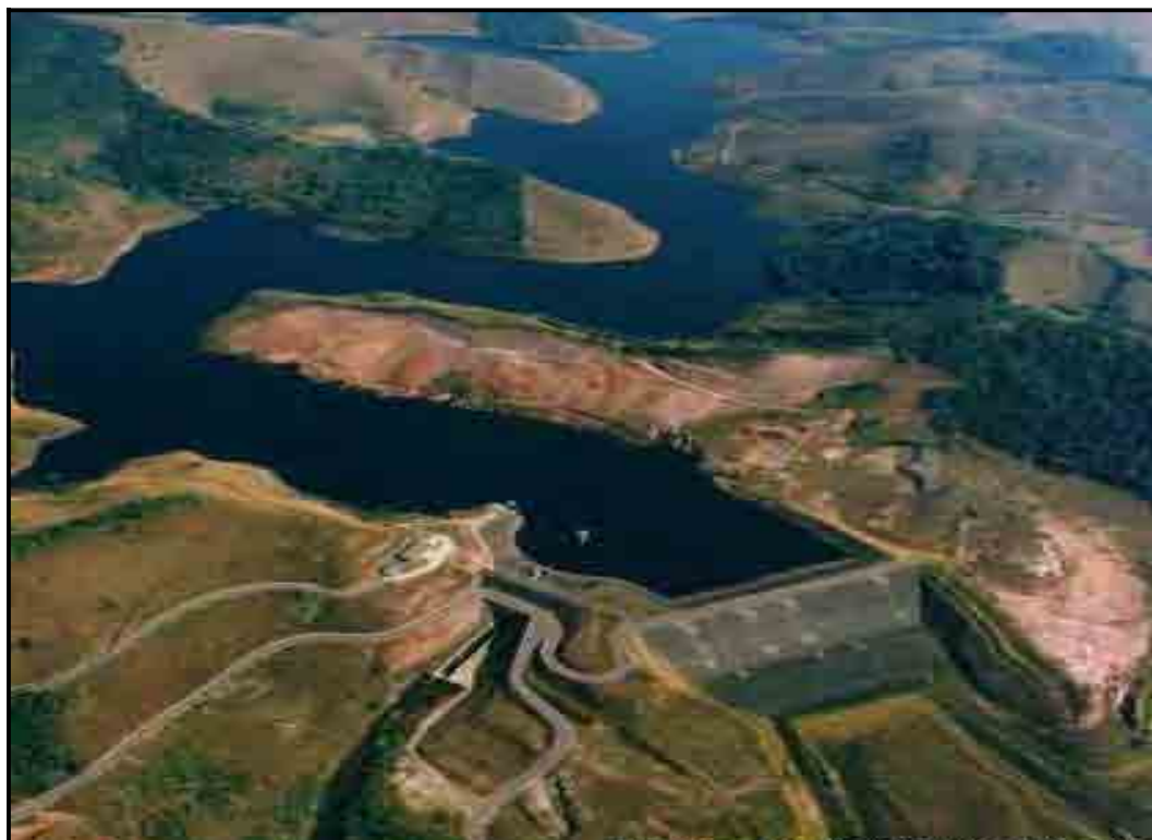
Figura 14 - Barragem de Chapéu D' uvas na Calha do Rio Paraibuna. Fonte: CESAMA, [199?] 26
