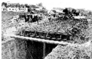
Fig. 37 Canalização Rio água Verde Fonte: gazeta do povo 31/out/1999
