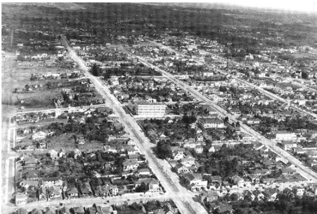
Fig. 48 Vista do Bairro Água Verde – 1942 FONTE: Gazeta do Povo, 31/out/1999
