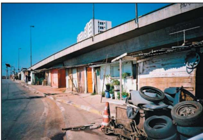
ocupação de espaços da infra-estrutura viária por favelados
