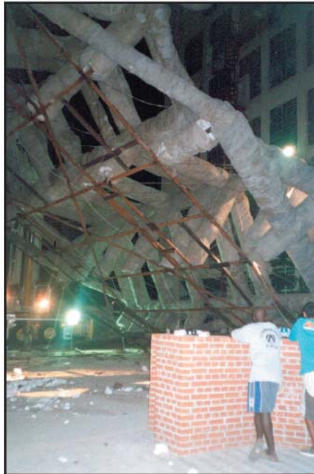
operação de içamento da peça para ser afixada sobre a fachada do edifício [arquivo de Andréia Moassab]
