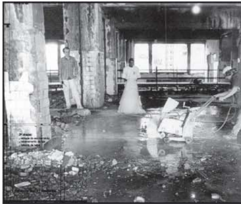
concretização da intervenção: corte da laje e início de sua descida [PEIXOTO, 2002]
