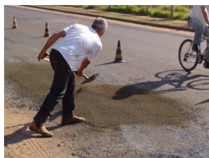
Figura 6.12 – Aplicação de pó de pedra
