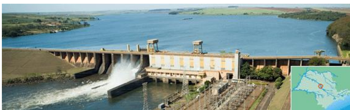
Figura 3: Reservatório de Bariri. Fonte: AES/TIETÊ AS (2006)
