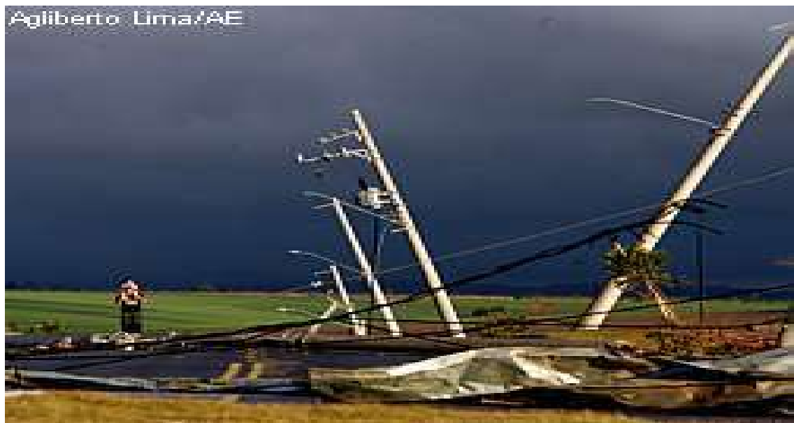
Figura 7 Efeitos nos postes de iluminação e rede elétrica causados pelo do tornado no dia 29 de maio de 2005 no município de Indaiatuba Estado de São Paulo, com ventos de 140 Km/h, afetando direta e indiretamente 170 mil habitantes. O prefeito José Onério (PDT) decretou estado de calamidade pública, por ficarem durante 24 horas sem energia elétrica (pelo colapso de três torres de alta tensão), água potável e telefonia fixa. Totalizando 222 postes colapsados da rede pública, 60 pessoas desabrigadas, 15 empresas totalmente destruídas e aproximadamente 400 empresas com danos razoáveis, na FERROBAN;18 vagões de 25 toneladas foram descarrilados pela força do vento.
