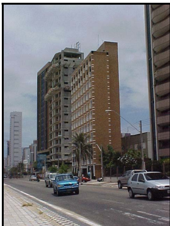
FIGURA 14 – Hotel em construção na Beira-Mar. FONTE – AMR/JEAM, 2005.
