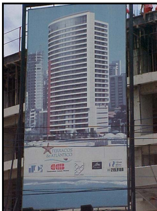
FIGURA 15 – Condomínio de luxo em construção na Beira-Mar FONTE – AMR/JEAM, 2005.
