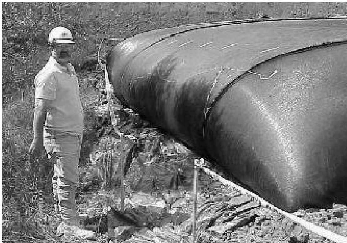
Figura 3.9: Tubo de geotêxtil preenchido até a altura de 1,5 m (Fowler et al 2002)
