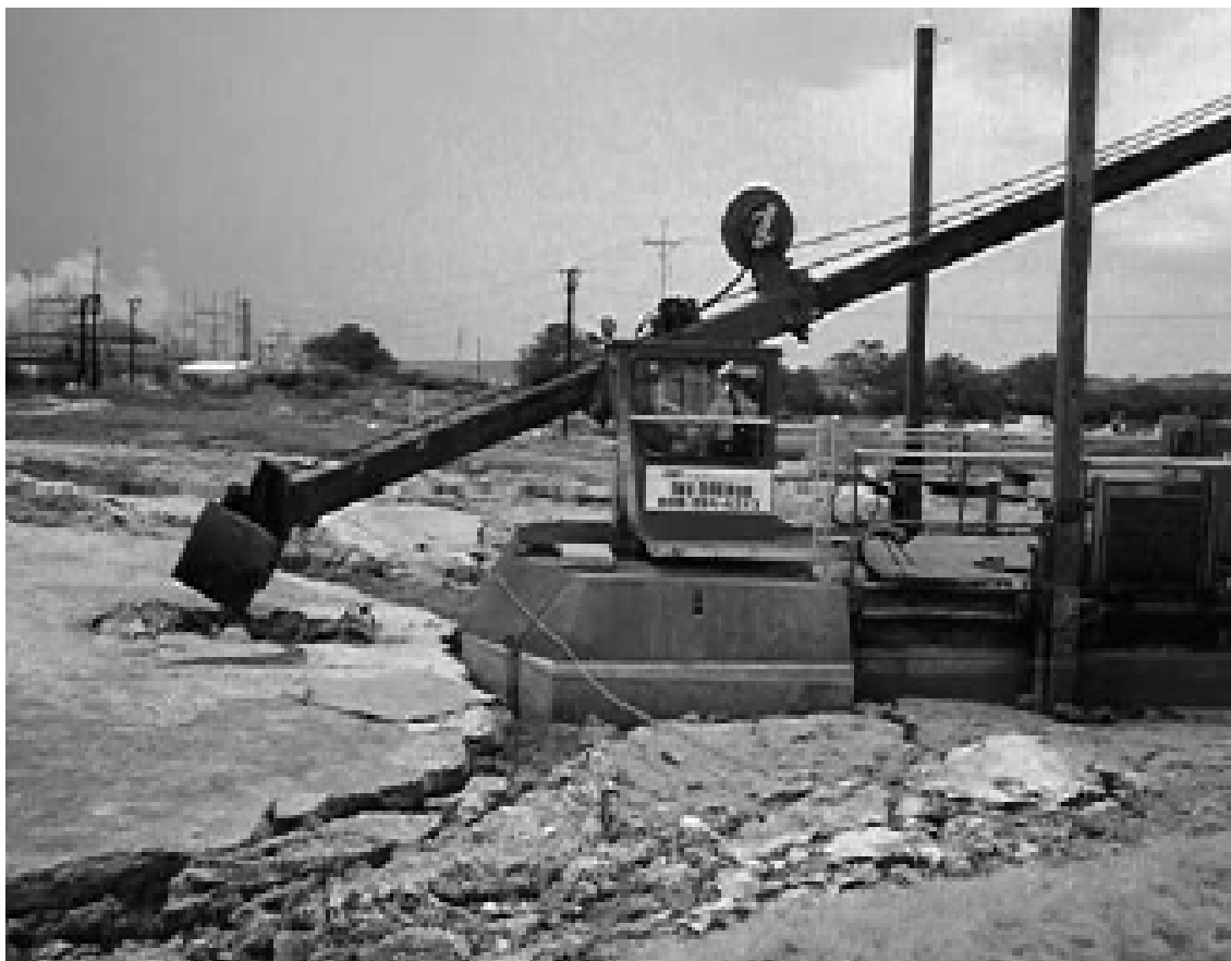
Figura 3.7: Dry DREdge™ removendo os sedimentos (Fowler et al).
