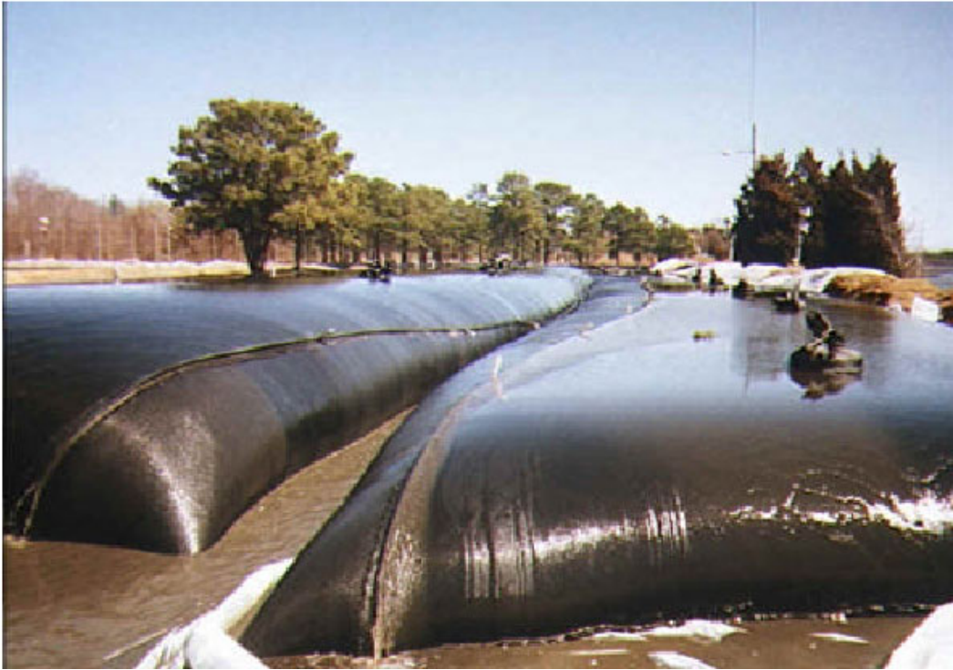
Figura 3.11: Tubos de geotêxtil preenchidos no pátio de desaguamento (Gaffney et al 2000).
