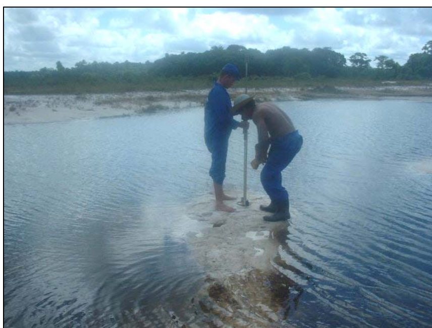
Figura 23: Cravação do DCP – Jazida, submersa
