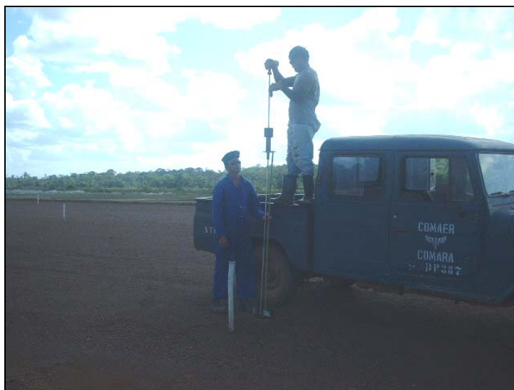
Figura 19: Cravação do DCP – Pavimento intacto
