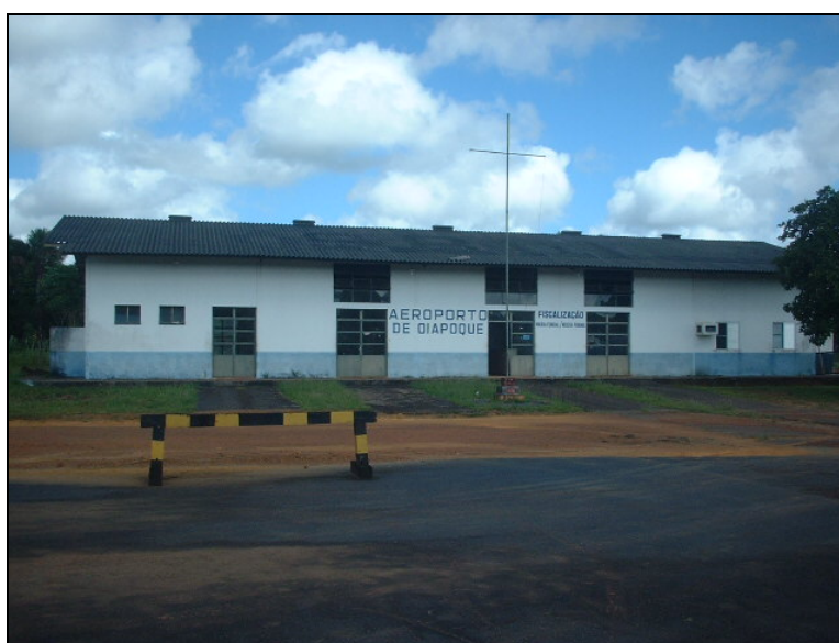
Figura 15: Terminal de passageiros do aeroporto de Oiapoque
