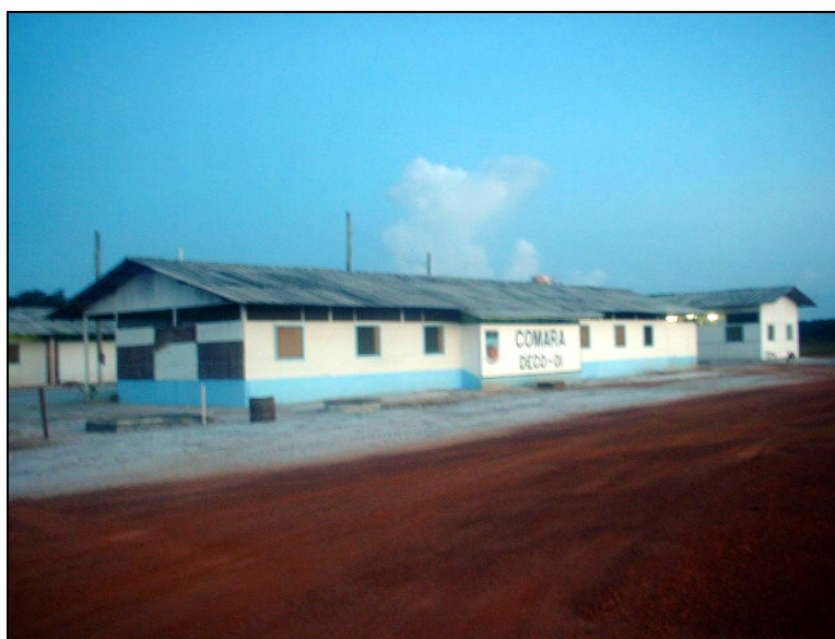
Figura 16: Canteiro de obras da COMARA em Oiapoque
