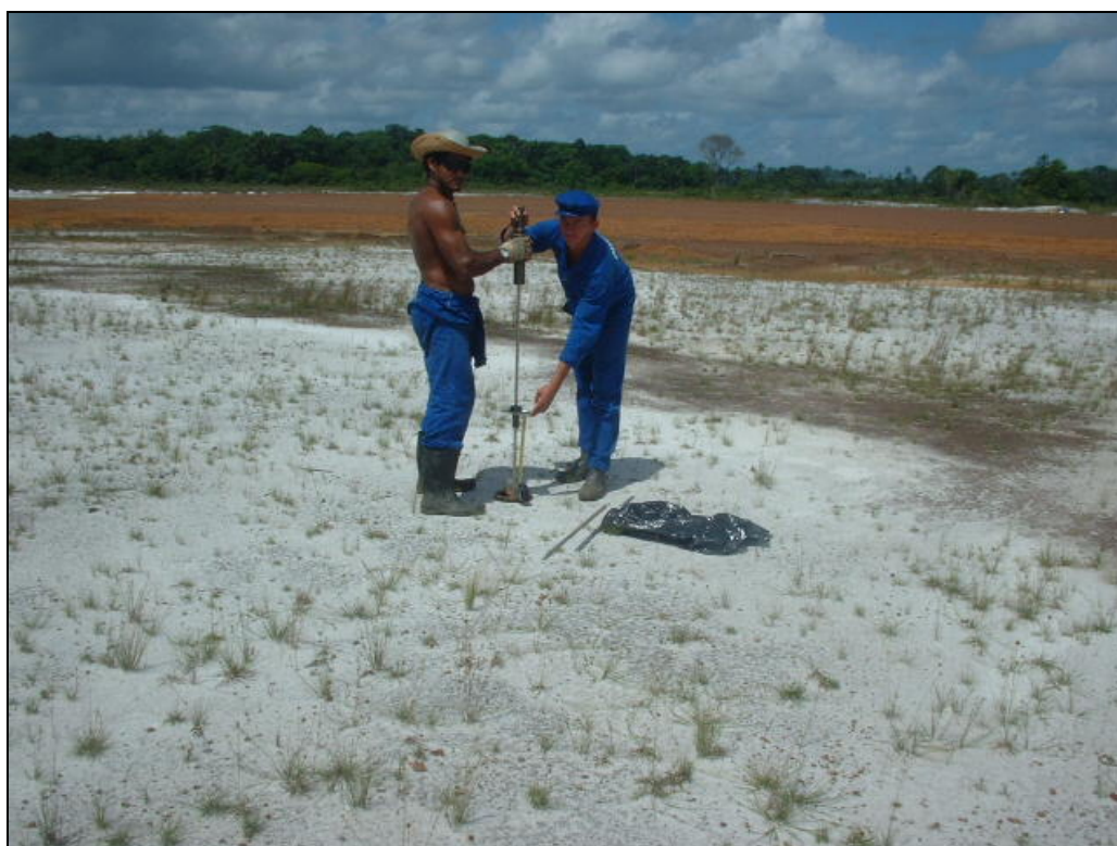
Figura 21: Cravação do DCP – Faixa de pista
