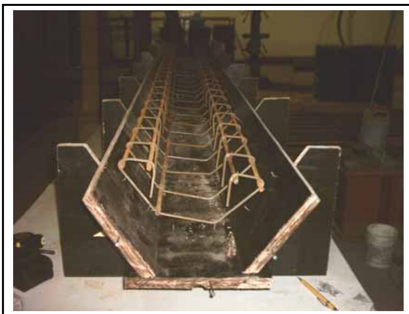
Figura 3.23 – Fôrmas usadas no reforço das vigas V1R e V2R.
