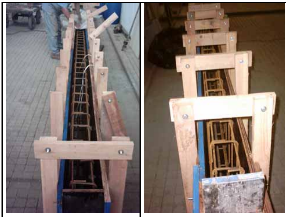
Figura 3.15 - Fôrmas usadas para concretagem das quatro vigas.
