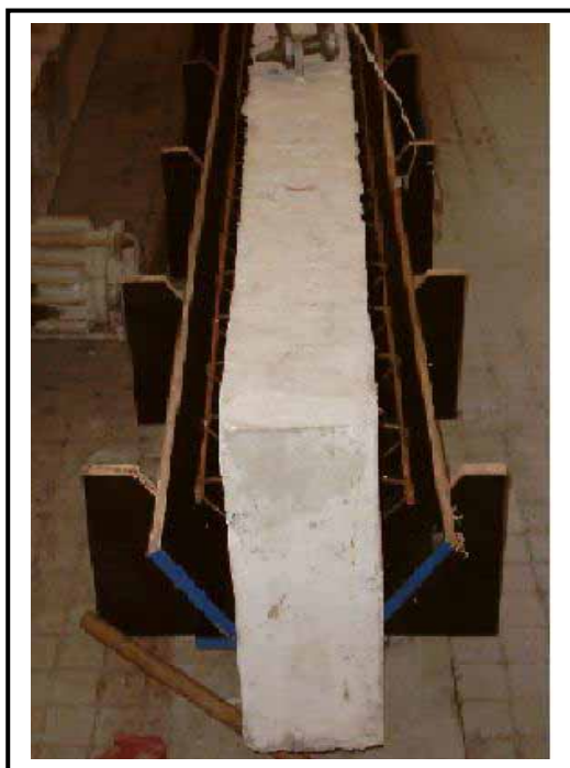
Figura 3.28 – Fôrma e armadura do reforço, posicionados na viga para concretagem.
