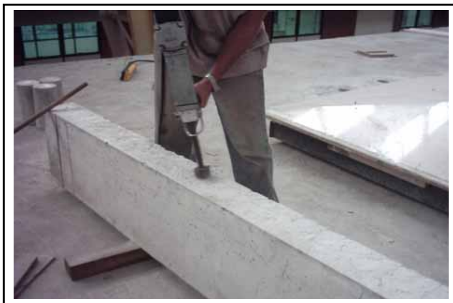
Figura 3.25 – Apicoamento com talhadeira elétrica no fundo de uma das vigas reforçadas.
