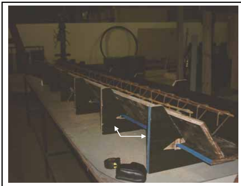
Figura 3.24 – Fôrmas do reforço; travamento com placas de compensado no fundo e nas laterais.
