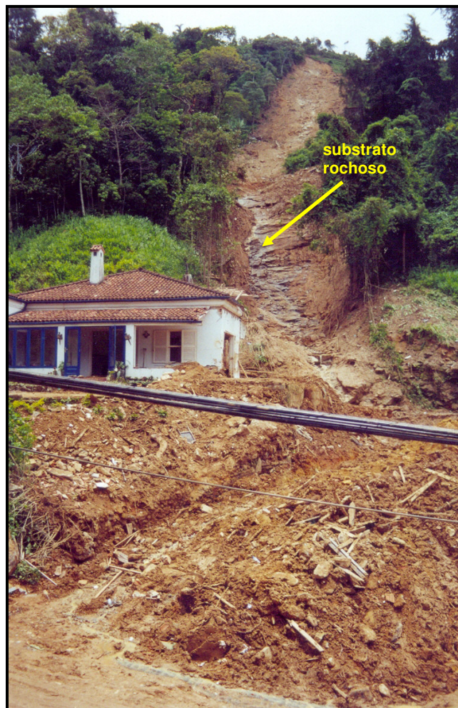
Figura 4.9 – Escorregamento ocorrido em dezembro de 2001 na Avenida Amaral Peixoto (Quitandinha), onde pode-se observar o substrato rochoso atingido (Fonte: NELSON FERREIRA FERNANDES).
