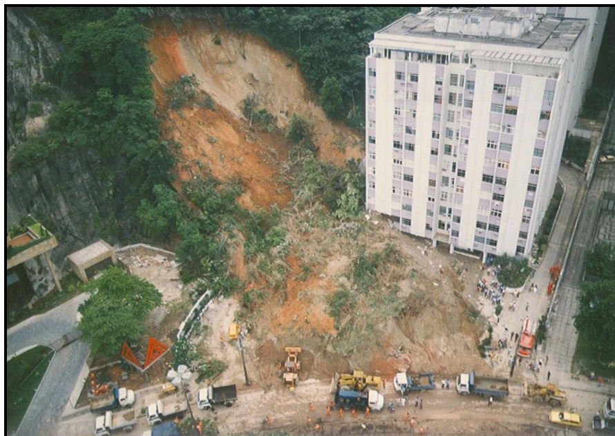
Figura 2.4 – Escorregamento rotacional ocorrido na Lagoa (corte do Cantagalo), Rio de Janeiro, no verão de 1988 (Fonte:WILLY LACERDA).
