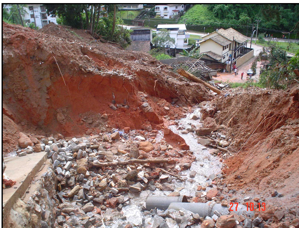
Figura 4.5 – Escorregamento ocorrido em dezembro de 2004 na Rua Itatiaia (Quitandinha), devido à ação antrópica (Fonte: Secretaria de Obras – Prefeitura Municipal de Petrópolis).
