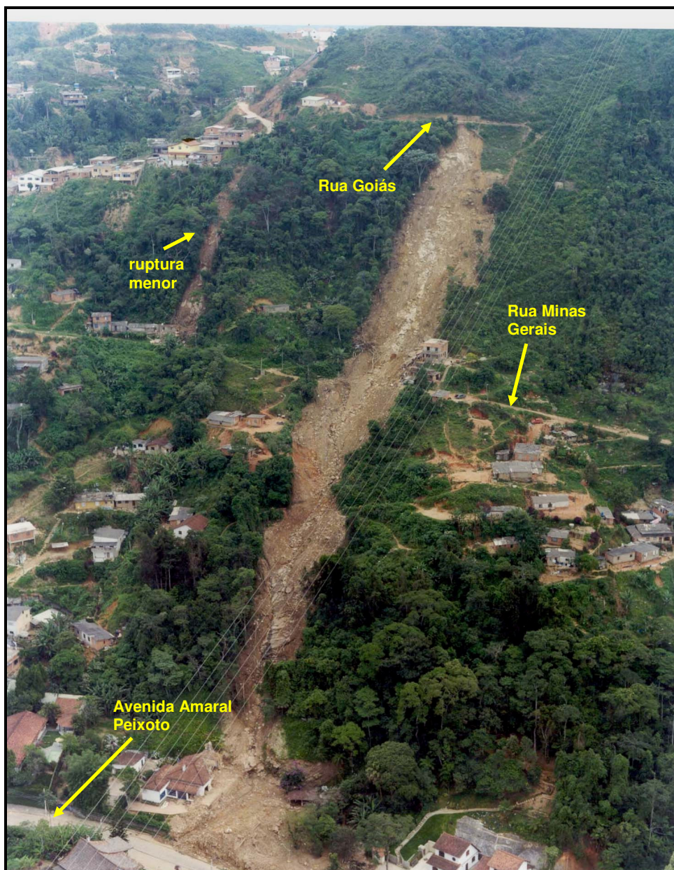
Figura 4.8 – Escorregamentos ocorridos em dezembro de 2001, na Avenida Amaral Peixoto, Rua Minas Gerais e Rua Goiás - Quitandinha (Fonte: Secretaria de Obras – Prefeitura Municipal de Petrópolis).
