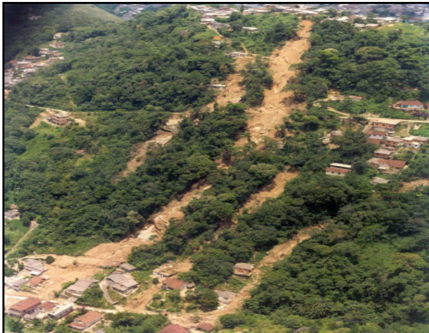
Figura 1.2 - Escorregamento ocorrido em dezembro de 1991 em Lopes Trovão (Fonte: Secretaria de Obras – Prefeitura Municipal de Petrópolis).
