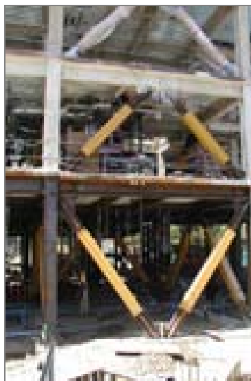
Figura 5.14: Vista de uma estrutura de pórticos com amortecedores.
