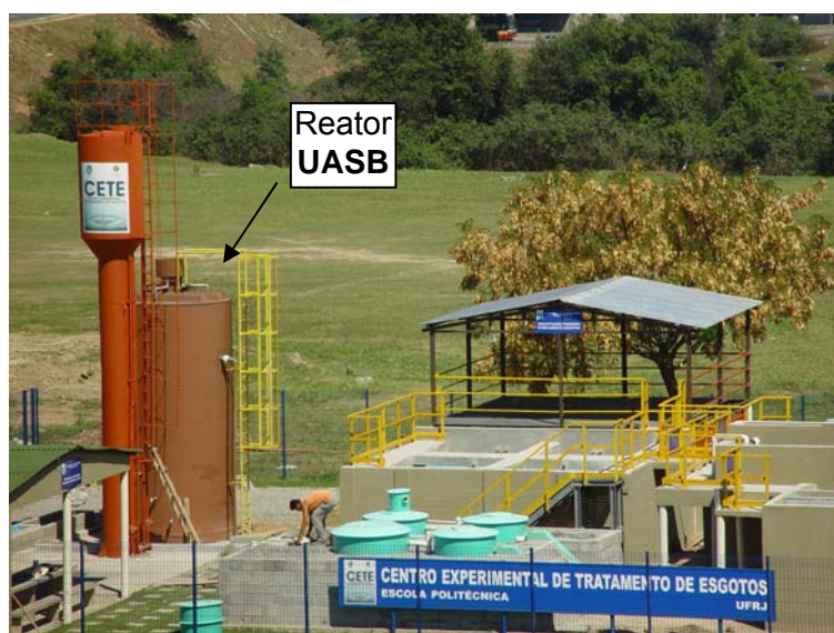
Figura 3.1 - Vista geral do CETE / UFRJ
