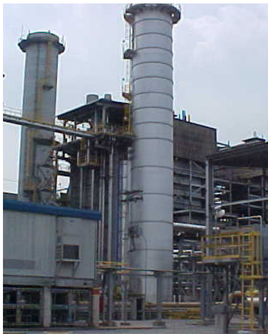
Figura 2.24 – Câmara de bypass .
