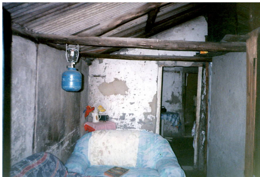
Figura 7. Casa de acampado
