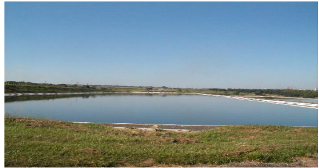
Figura 1.2: Estação de tratamento de Lins/SP: entrada do esgoto na estação e lagoas anaeróbia e facultativa.
