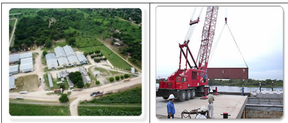
Foto 04: Infraestrutura portuária de Puerto Aguirre
