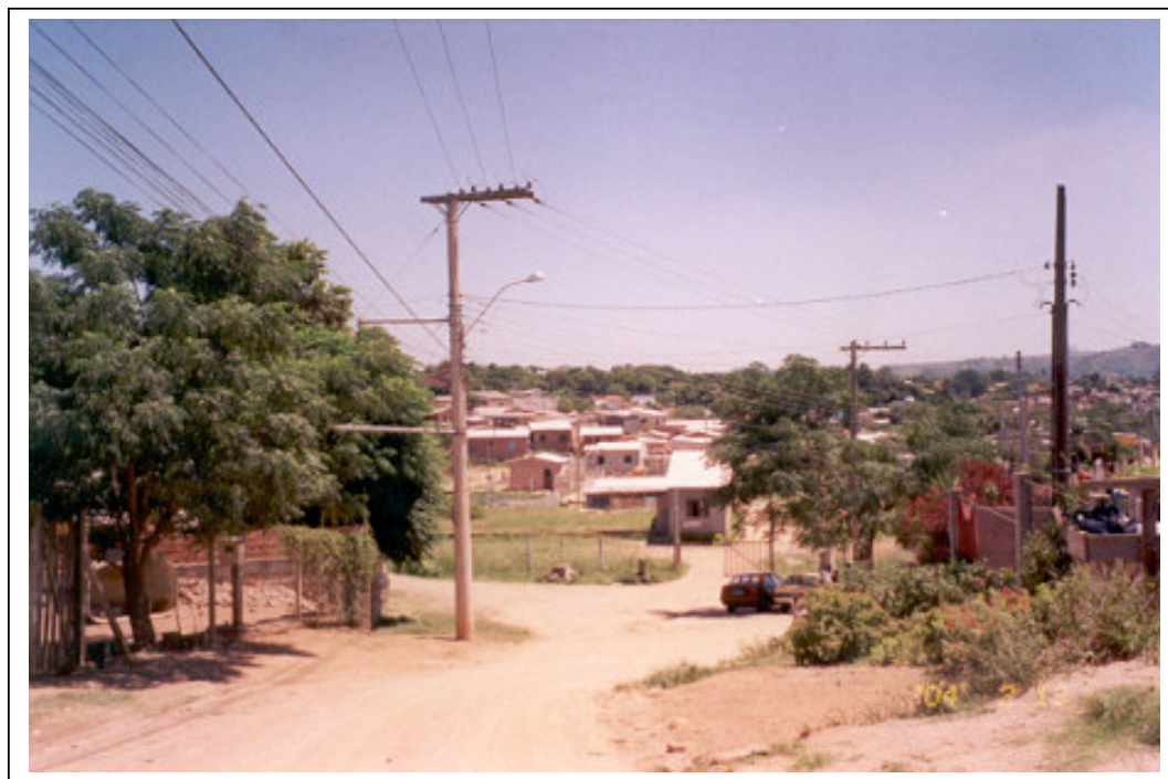
FIGURA 11 – FOTO DO ACESSO PRINCIPAL PARA A VILA ELO DOURADO.
