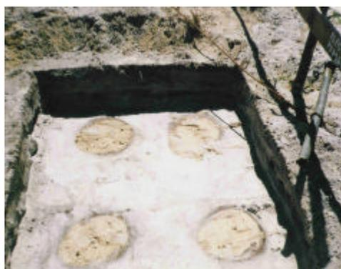
Figura 2.6 – Estacas de compactação prontas (Copesolo, 2005)
