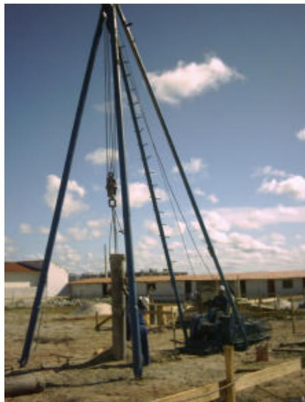
Figura 2.5 - Bate-estacas usado na execução de estacas de areia (Soares & Soares, 2004)
