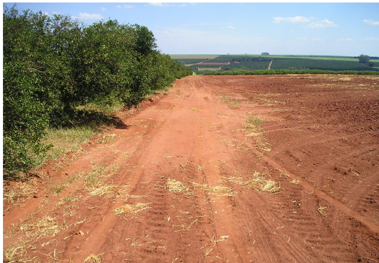
Figura 4 - Modificações de superfície que provocam perdas de função do perfil transversal (NvE-385, Nova Europa, estado de São Paulo, agosto de 2004)
