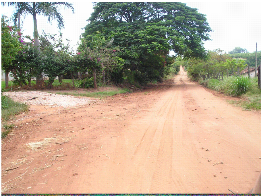
Figura 1 - Rodovia não-pavimentada de boas condições de tráfego, foto do autor, em fevereiro de 2005, Nova Europa, estado de São Paulo, Brasil, um ambiente rural
