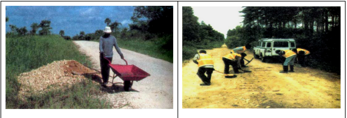
Figura 19 – Operações manuais de manutenção de rodovias não-pavimentadas (PIARC, 1982)
