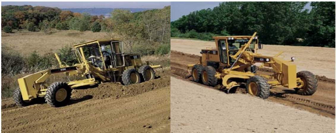
Figura 16 – Raspagem para manutenção de via não-pavimentada ( http://cmms.cat.com )
