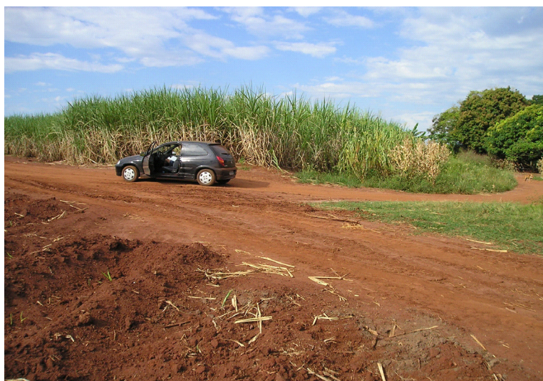
Figura 6 - Movimento de materiais que provoca modificações e alterações na forma das curvas e superelevação - (Rodovia NvE-060, Nova Europa, estado de São Paulo, outubro de 2004)
