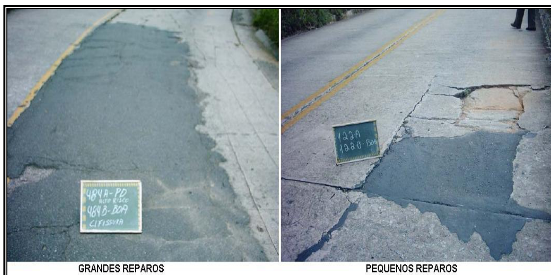
Figura 3.15: Tipos de Reparos, DNIT (2004)
