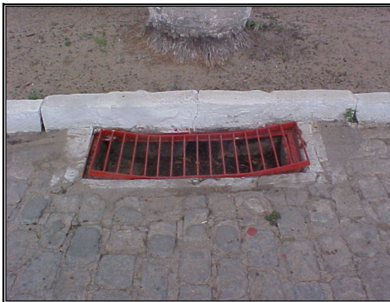
Figura 6.13: Drenagem no Trecho Calçado com Paralelepípedos
