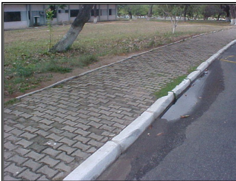
Figura 6.12: Drenagem no Trecho Asfaltado
