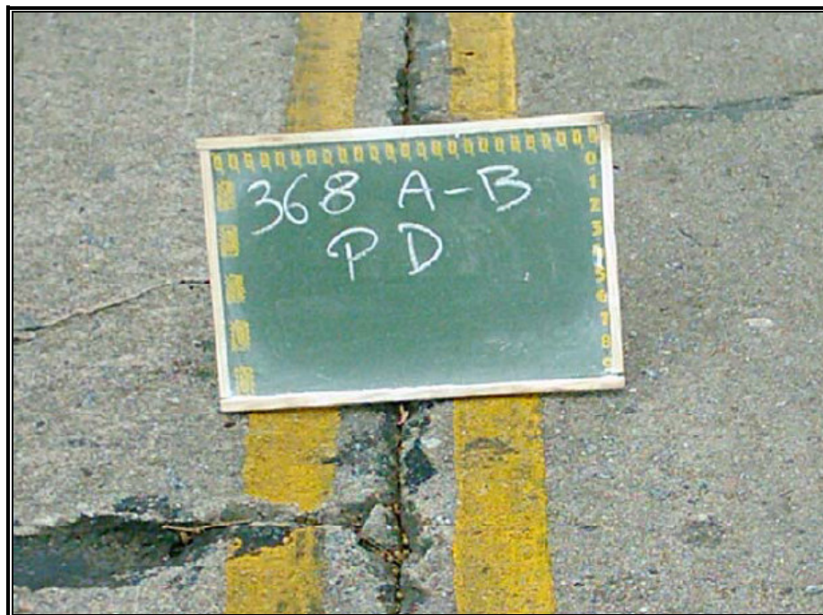
Figura 3.21: Quebra de Juntas, DNIT (2004)
