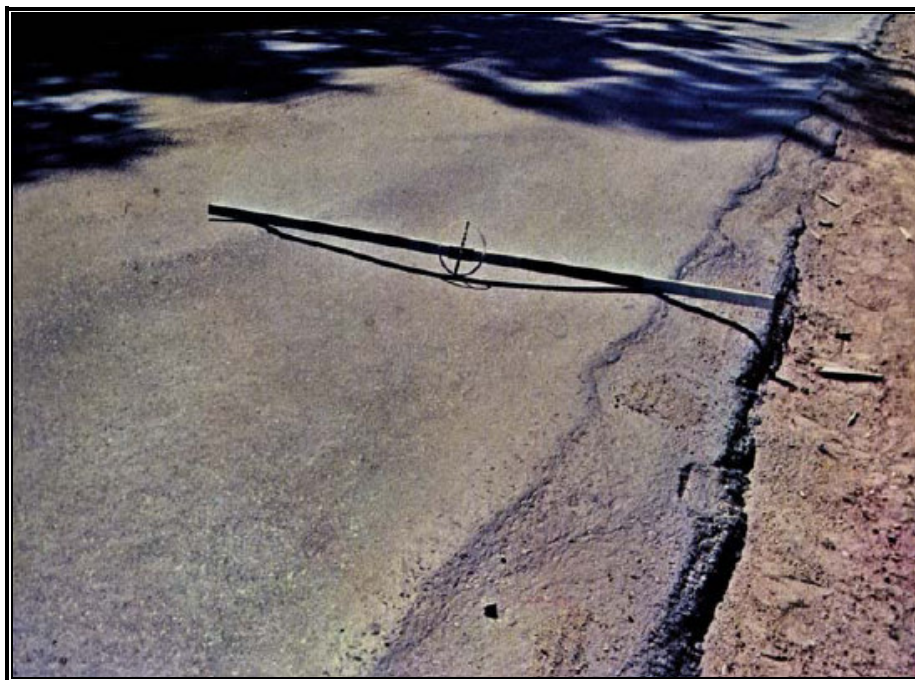
Figura 3.8: Afundamento de Trilha de Roda, DNIT (2003)
