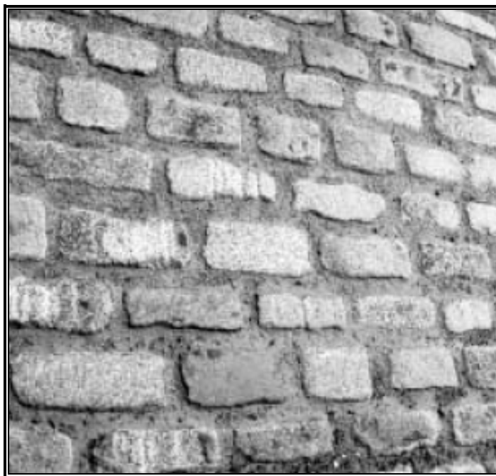
Figura 5.10: Exemplo de Revestimentos de Calçamento em Paralelepípedos
