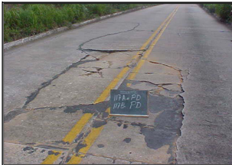
Figura 3.12: Placa Dividida, DNIT (2004)
