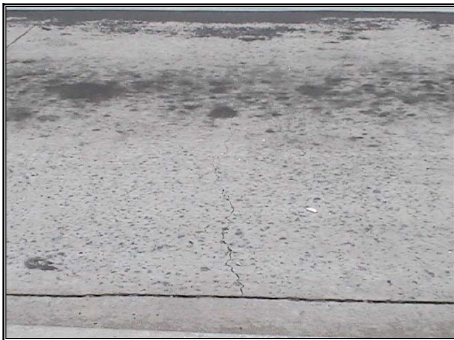
Figura 3.16: Desgaste Superficial, DNIT (2004)
